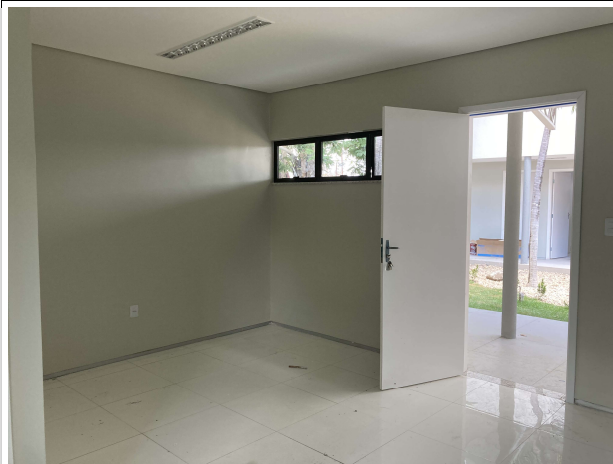
Fig. 9 – Execução de pintura, esquadrias e forro
