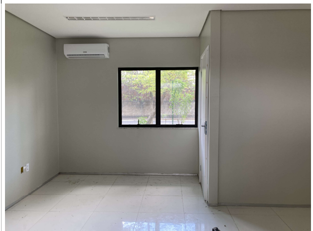
Fig. 6 – Execução de pintura, esquadrias e instalações
