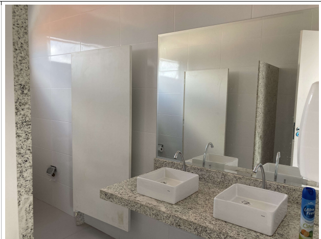
Fig. 16 – Execução de esquadrias e louças
