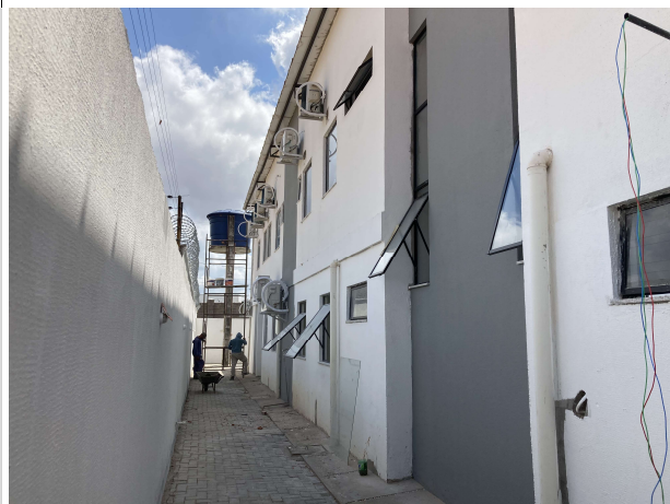
Fig. 11 – Execução de pintura da fachada
