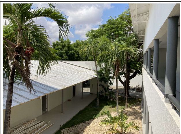
Fig. 14 – Execução de cobertura
