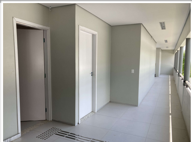
Fig. 18 – Execução de instalações, pinturas e forro
