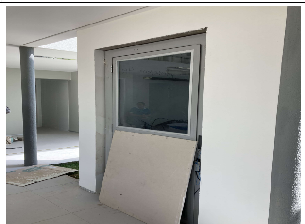
Fig. 20 – Execução de plataforma elevatória
