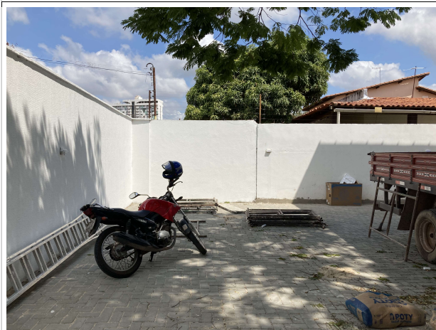
Fig. 17 – Execução de muro, instalações e pavimento
