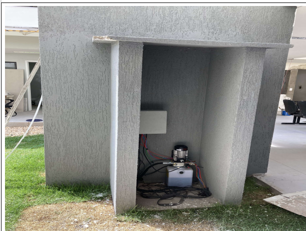
Fig. 19 – Execução de plataforma elevatória
