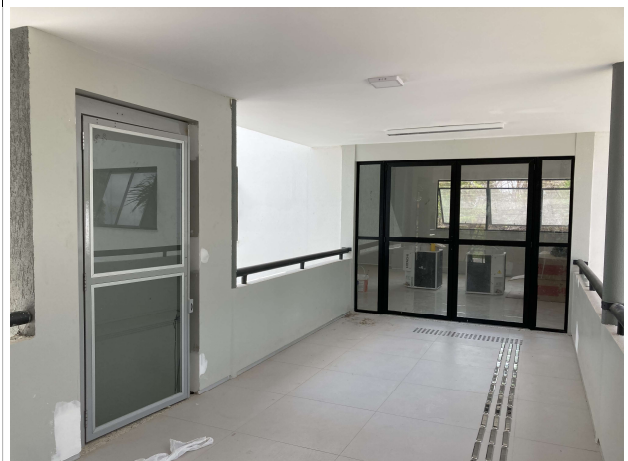
Fig. 12 – Execução de forro, piso tátil e esquadrias
