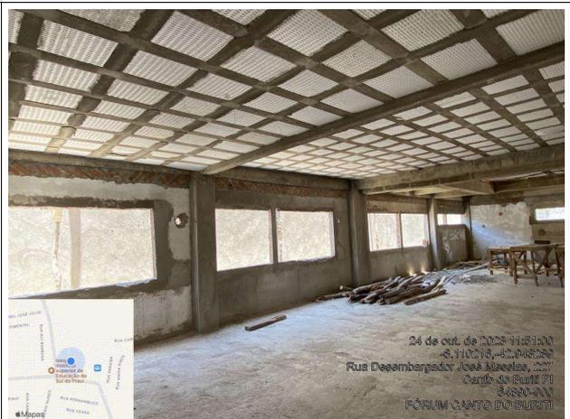
Fig. 8 – execução de laje
