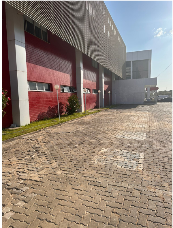
Fig. 42 – Ligações água, esgoto e pluviais finalizadas
