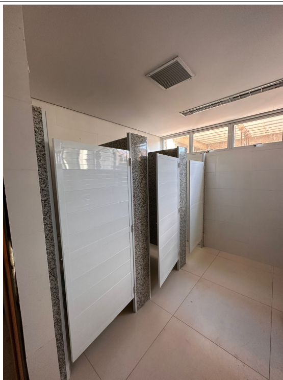
Fig. 11 – Portas de alumínio banheiros EJUD
