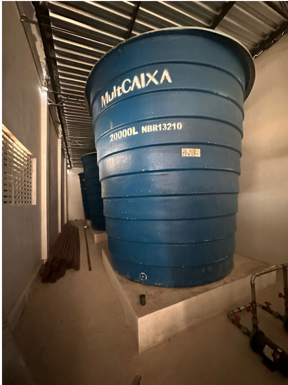
Fig. 37 – Caixas de água Cisterna
