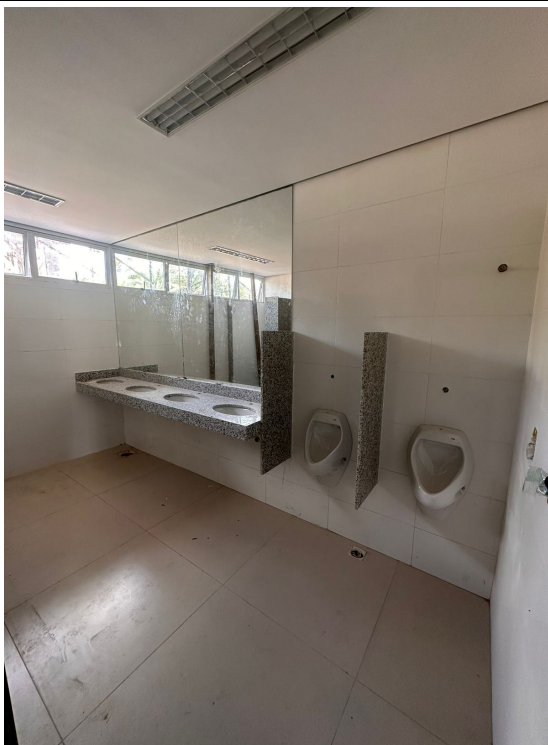
Fig. 11 – Banheiro masculino EJUD
