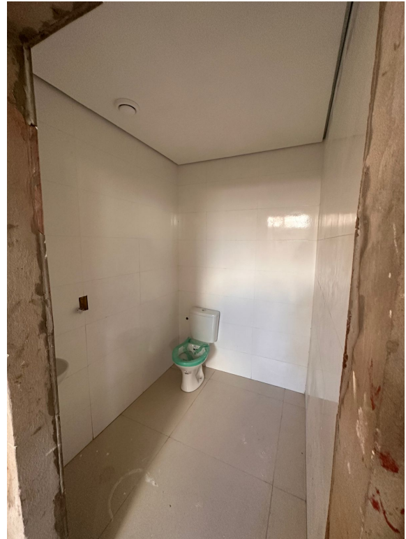
Fig. 10 – Banheiro acessibilidade EJUD
