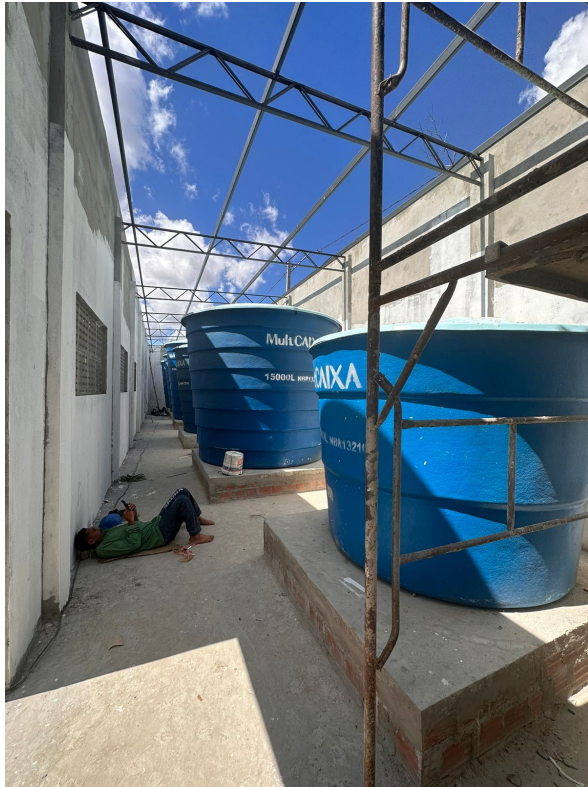
Fig. 41 – Reservatórios Cisterna
