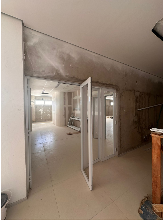
Fig. 13 – execução de piso e instalações
