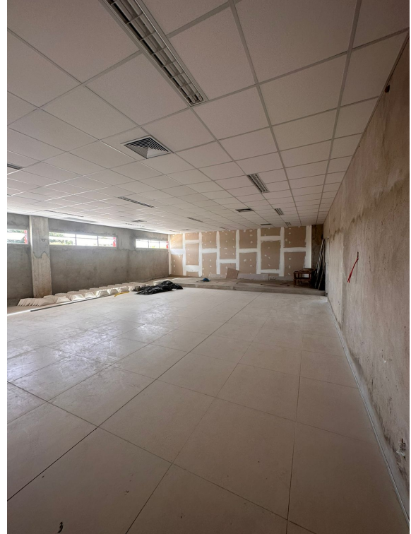
Fig. 14 – execução de piso e esquadrias
