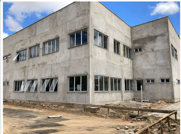
Fig. 2 – esquadrias da EJUD
