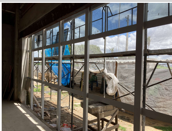
Fig. 5 – execução da fachada em pele de vidro
