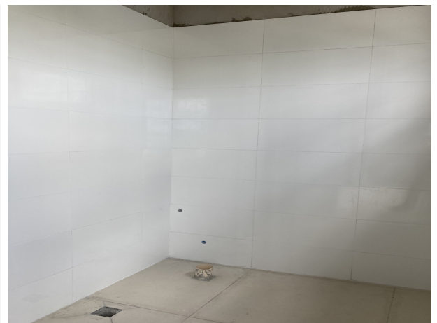
Fig. 14 – revestimento cerâmico dos banheiros
