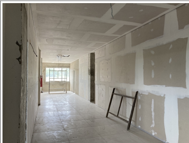
Fig. 11 – execução de forro e parede de gesso
