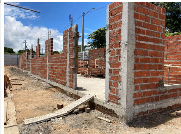
Fig. 4 – estrutura da cisterna
