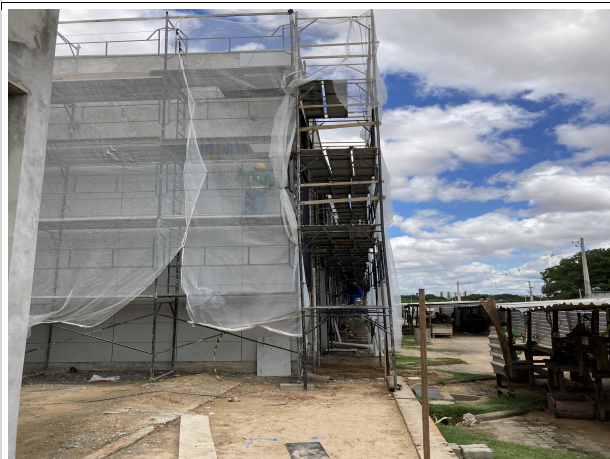
Fig. 9 – execução da fachada ventilada
