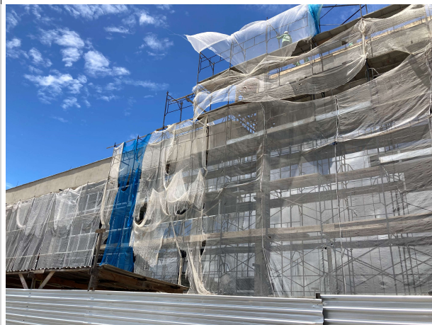
Fig. 7 – execução da fachada em pele de vidro
