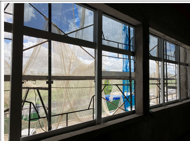
Fig. 6 – execução da fachada em pele de vidro
