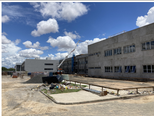
Fig. 3 – concretagem da caixa d'água
