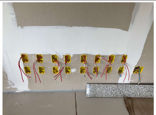
Fig. 10 – execução de instalação lógica
