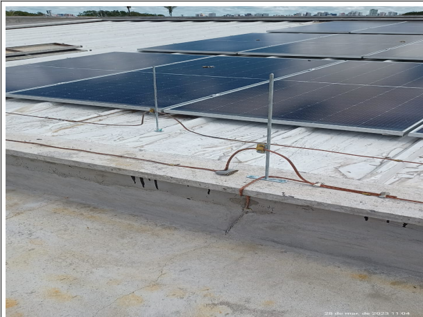
Fig. 23 – execução de SPDA
