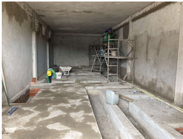
Fig. 1 – estrutura da subestação
