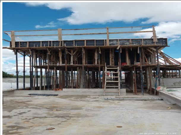
Fig. 21 – concretagem da caixa d'água
