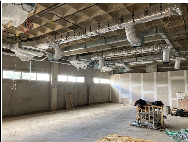
Fig. 17 – execução de rede frigorígena
