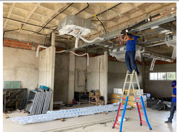
Fig. 18 – execução de rede frigorígena
