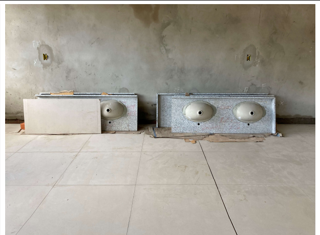
Fig. 16 – bancadas de granito da Corregedoria
