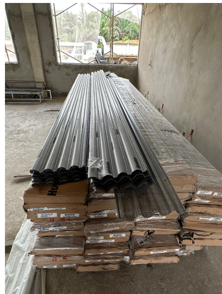
Foto 20 – Brise metálico Corregedoria
