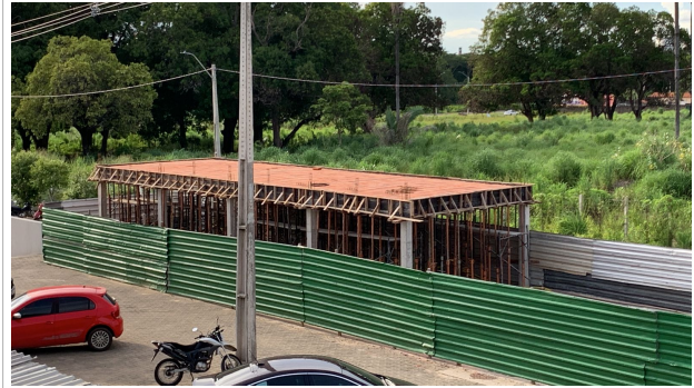
Foto 26 – Laje da Subestação
