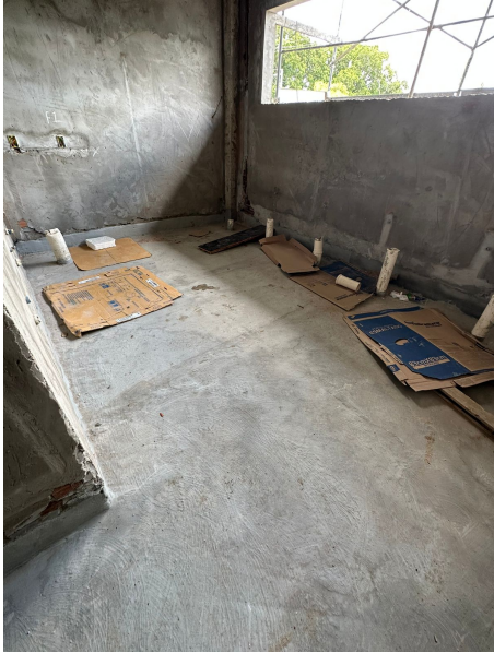
Foto 21 – Instalações hidro sanitárias banheiros Corregedoria
