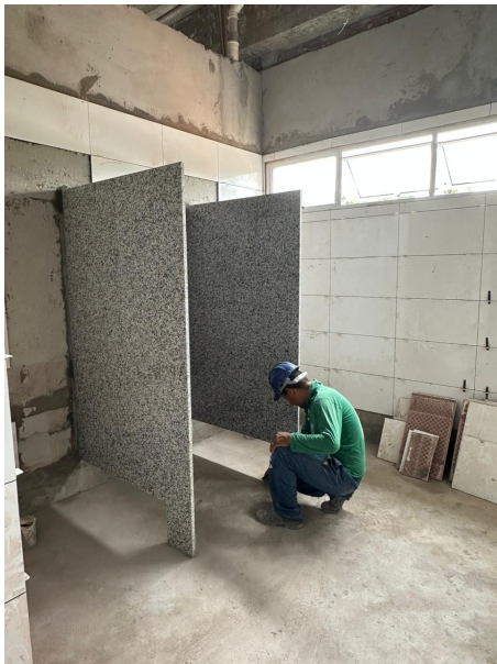
Foto 7 – Divisórias banheiros EJUD
