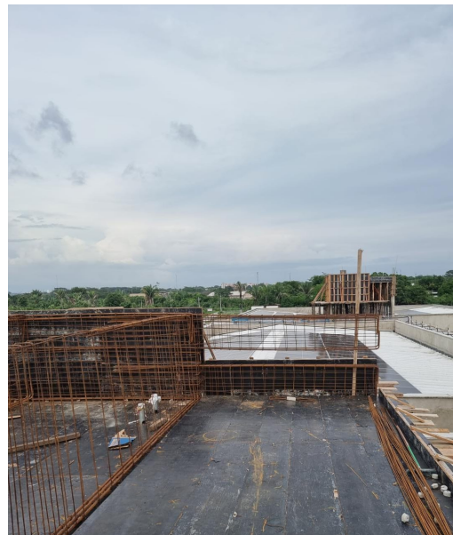
Foto 24 – Ferragem e forma das caixas de água Corregedoria e EJUD
