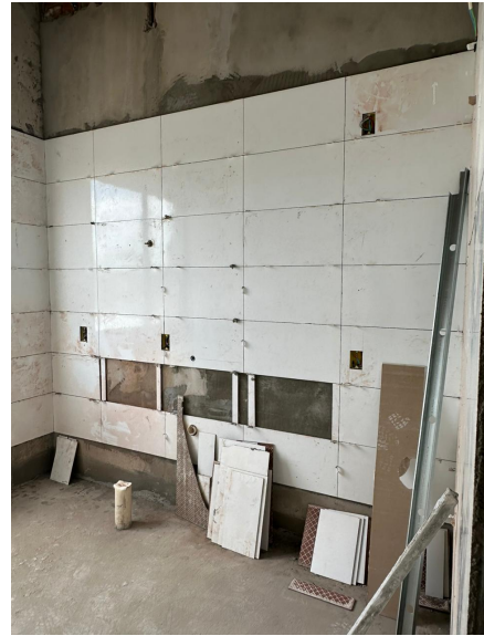
Foto 6 – Revestimento cerâmico banheiros EJUD
