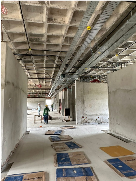
Foto 17 – Calhas e instalações Corregedoria
