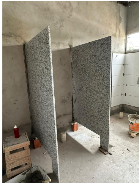
Foto 8 – Divisórias banheiros EJUD
