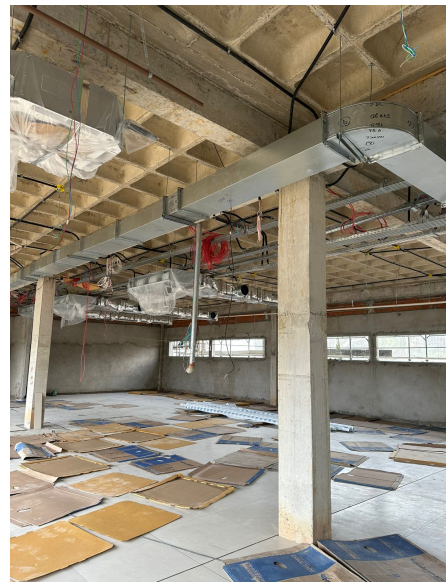
Foto 12 – Calhas e instalações Corregedoria
