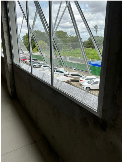
Foto 5 – Esquadrias metálicas e peitoril de granito EJUD
