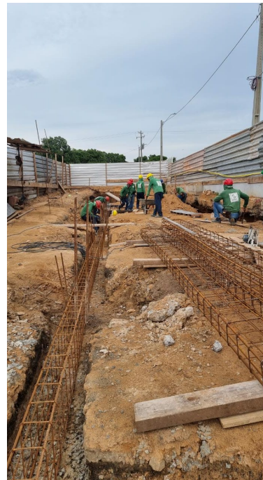
Foto 28 – Ferragem fundação cisterna
