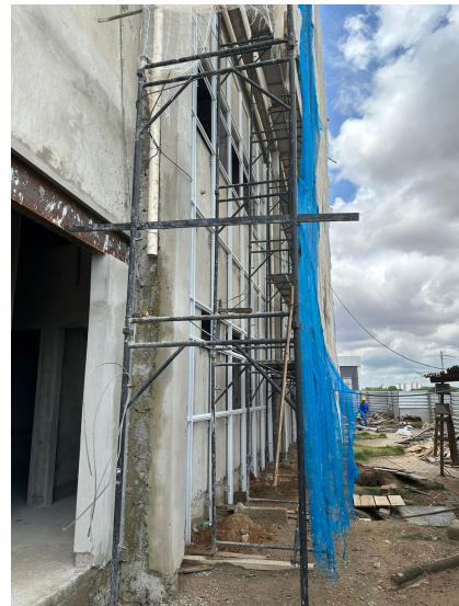
Foto 16 – Fachada de vidro Corregedoria
