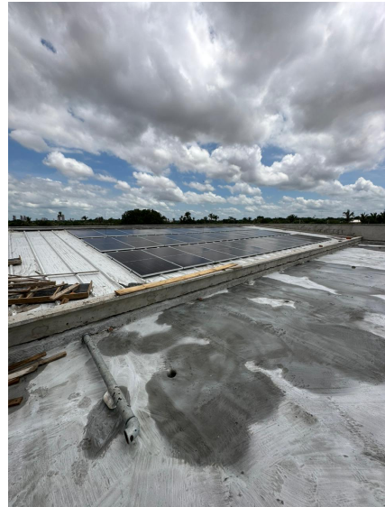
Foto 10 – Cobertura metálica, telha termoacústica e fotovoltaica da EJUD
