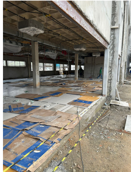
Foto 18 – Revestimento cerâmico Corregedoria
