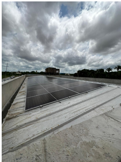
Foto 12 - Cobertura metálica, telha termoacústica e fotovoltaica da Corregedoria
