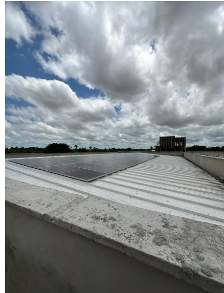
Foto 14 - Cobertura metálica, telha termoacústica e fotovoltaica da Corregedoria
