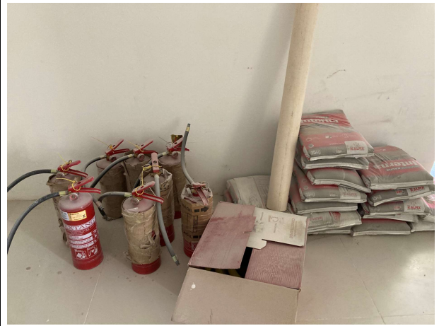
Fig. 14 – Extintores de incêndio
