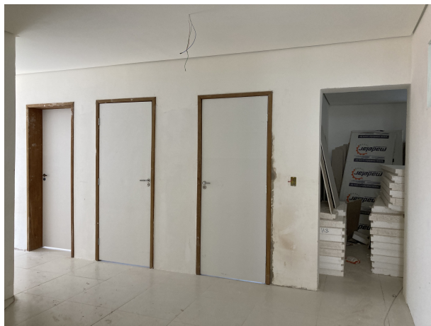
Fig. 7 – Execução de portas
