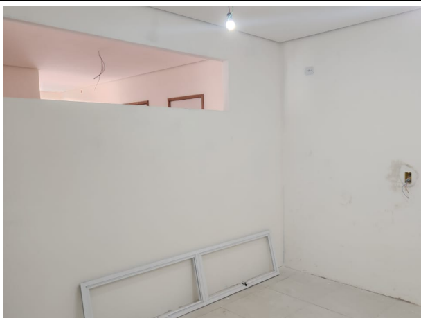
Fig. 3 – Forro e parede de drywall
