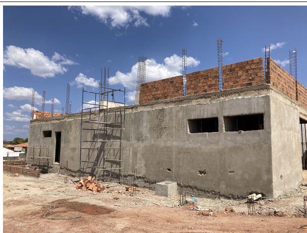
Fig. 11 – Execução de estrutura e alvenaria
