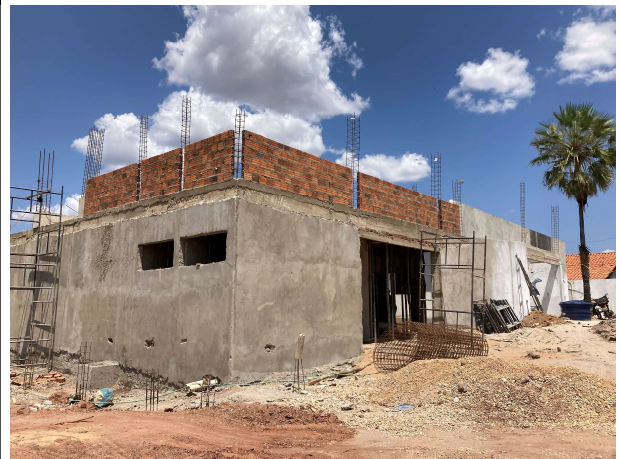
Fig. 2 – Bloco do Auditório
