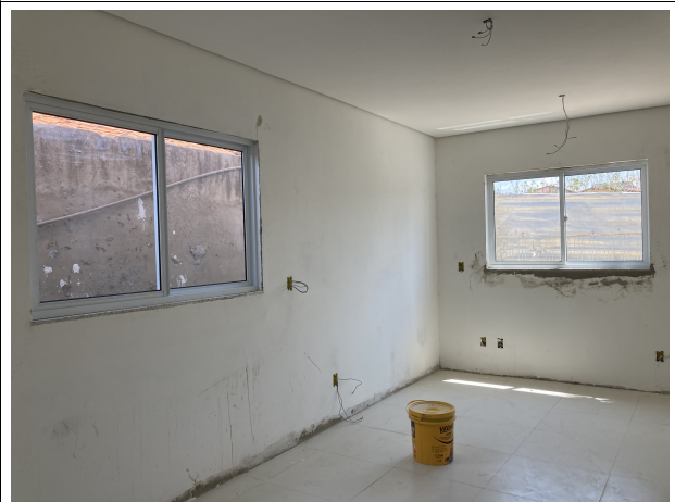
Fig. 6 – Execução de forro e esquadrias
