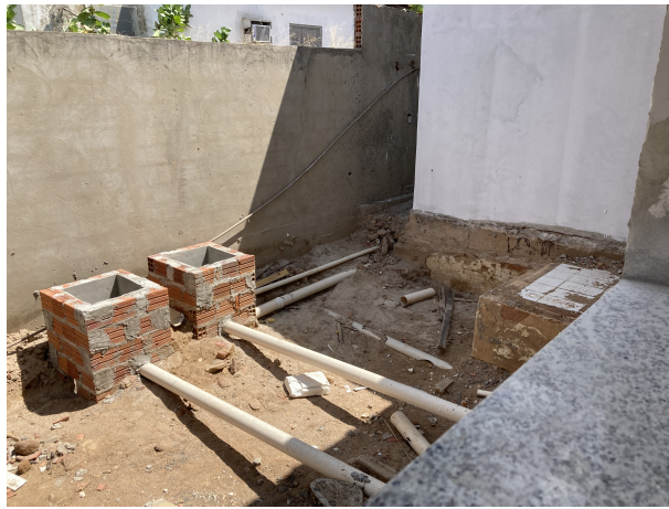
Fig. 13 – Peitoril e instalações hidrossanitárias
