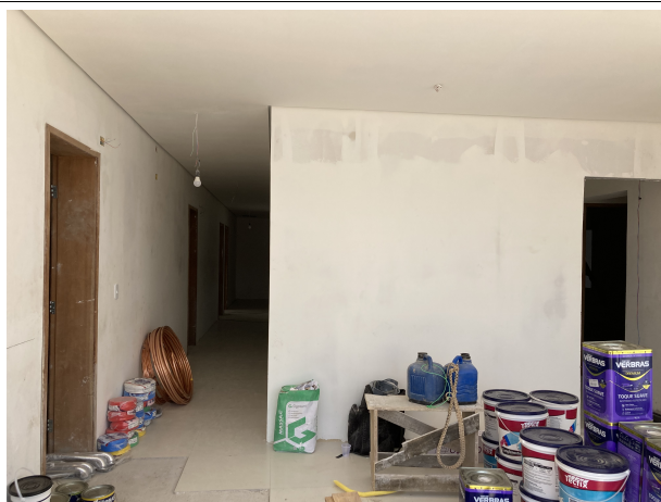
Fig. 5 – Execução de pintura
