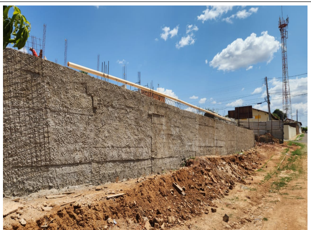
Fig. 12 – Execução de muro
