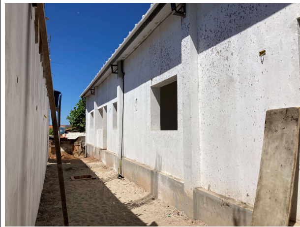
Fig. 13 – exterior do bloco do Fórum
