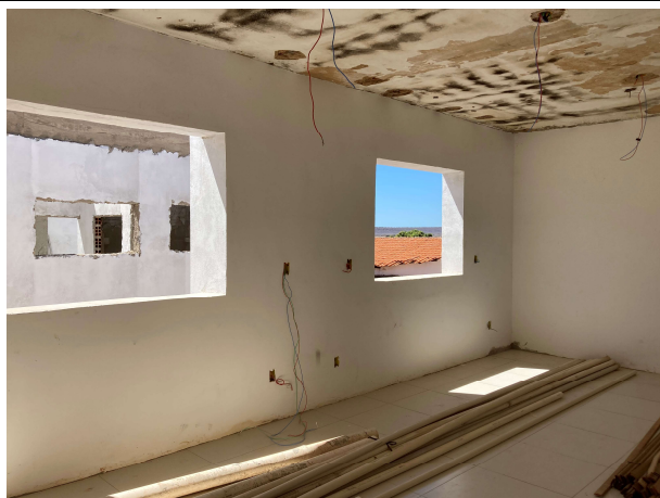
Fig. 3 – interior do Fórum em reforma
