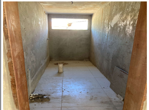
Fig. 14 – banheiro do bloco do Fórum
