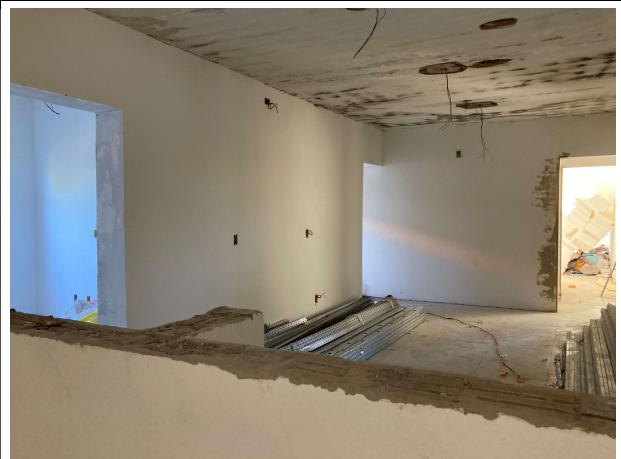
Fig. 4 – interior do Fórum em reforma
