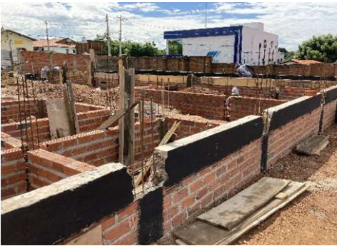
VIGAS/BALDRAMES/ARRANQUE DE PILARRES
