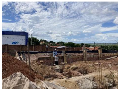
FUNDAÇÕES/MOVIMENTAÇÃO DE TERRA
