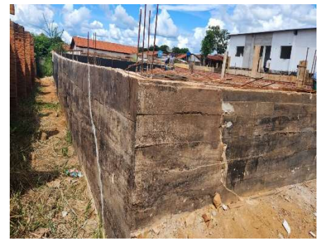
MURO DE ARRIMO
