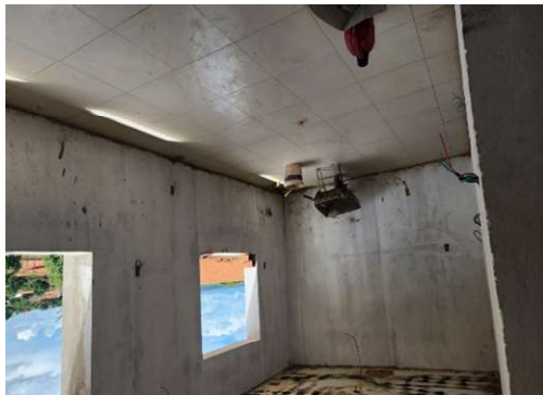
DEMOLIAÇÃO DE PISO/REBOCO/ELÉTRICA
