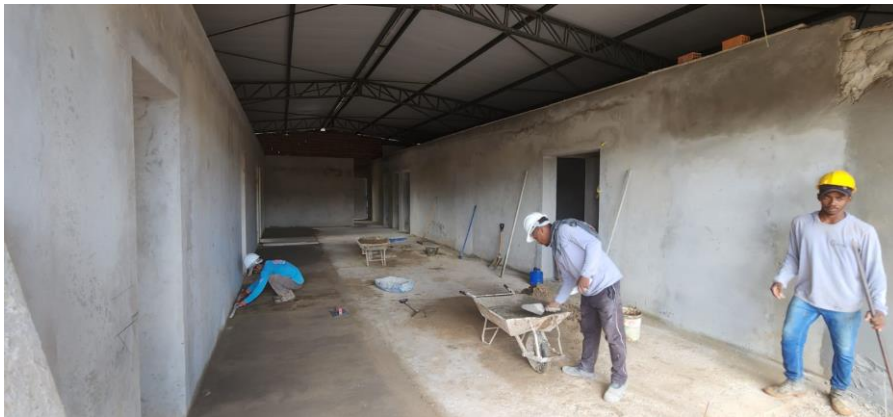
FOTO 4 – CONTRAPISO, REBOCO E COBERTURA
