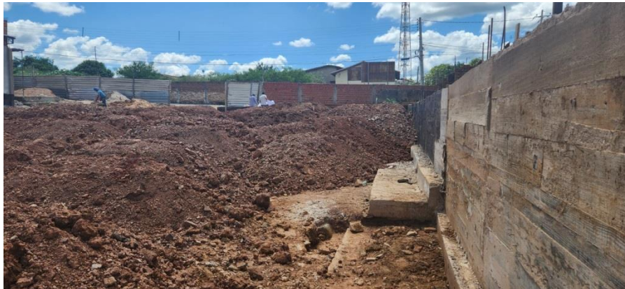
FOTO 15 – ATERRO E MURO DE ARRIMO
