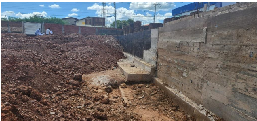
FOTO 18 – ATERRO E MURO DE ARRIMO
