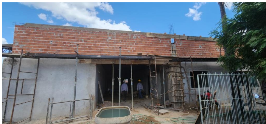
FOTO 1 – FACHADA PRINCIPAL – REBOCO E ALVENARIA
