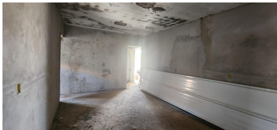
FOTO 8 – CONTRAPISO, REBOCO E ELÉTRICA
