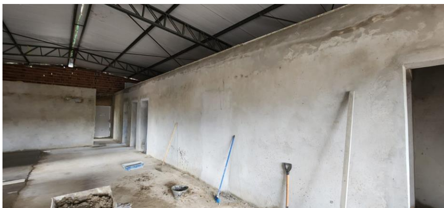
FOTO 5 – CONTRAPISO, REBOCO E COBERTURA
