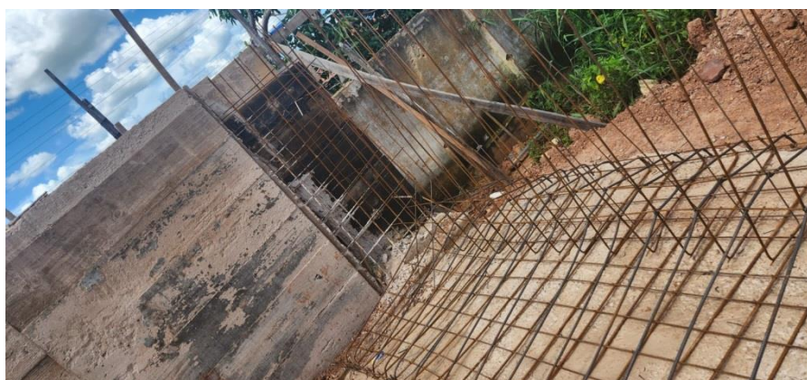
FOTO 19 – MURO DE ARRIMO E ARMAÇÃO
