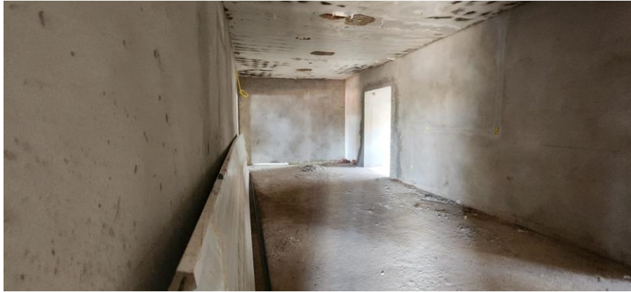
FOTO 9 – CONTRAPISO, REBOCO E ELÉTRICA
