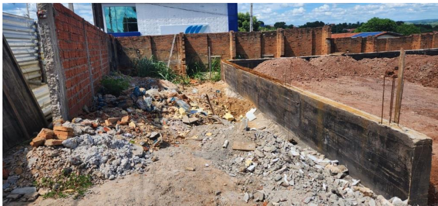
FOTO 16 – ATERRO E MURO DE ARRIMO
