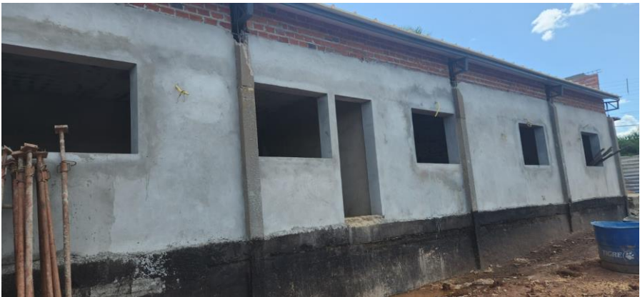
FOTO 13 – REBOCO, BALDRAME, PILARES E IMPERMEABILIZAÇÕES
