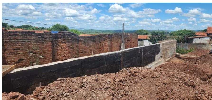
FOTO 17 – ATERRO E MURO DE ARRIMO
