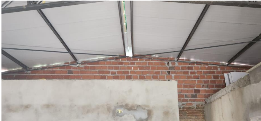
FOTO 3 – ALVENARIA E COBERTURA
