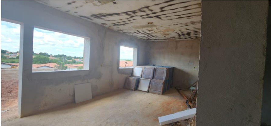
FOTO 6 – CONTRAPISO E REBOCO
