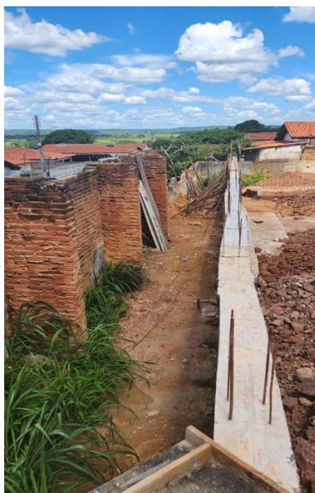
FOTO 20 – MURO DE ARRIMO
