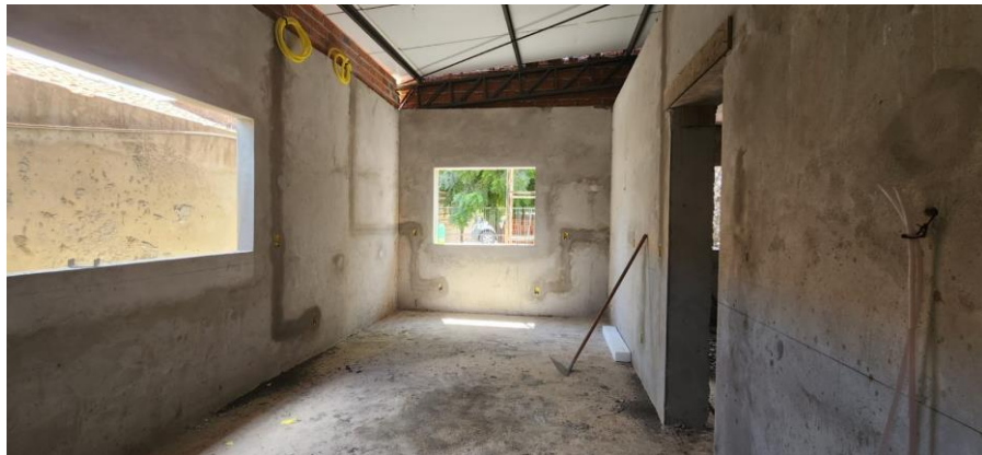
FOTO 10 – CONTRAPISO, REBOCO, ELÉTRICA E COBERTURA
