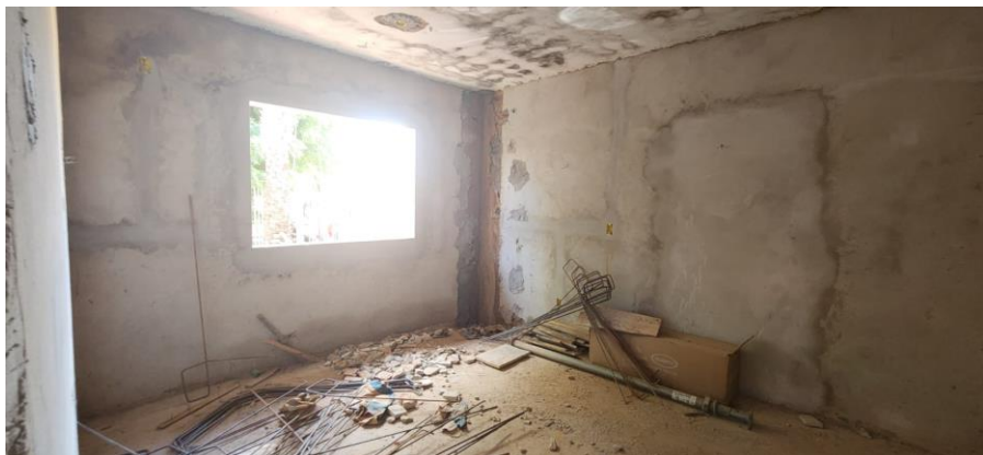
FOTO 11 – CONTRAPISO, REBOCO E ELÉTRICA
