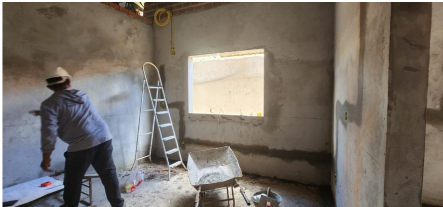
FOTO 7 – CONTRAPISO, REBOCO E ELÉTRICA
