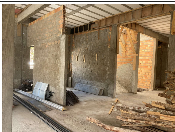
Fig. 6 – Execução de revestimentos
