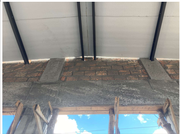
Fig. 8 – Estrutura metálica e telhamento
