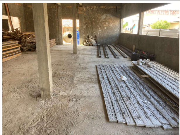
Fig. 10 – Treliças da superestrutura
