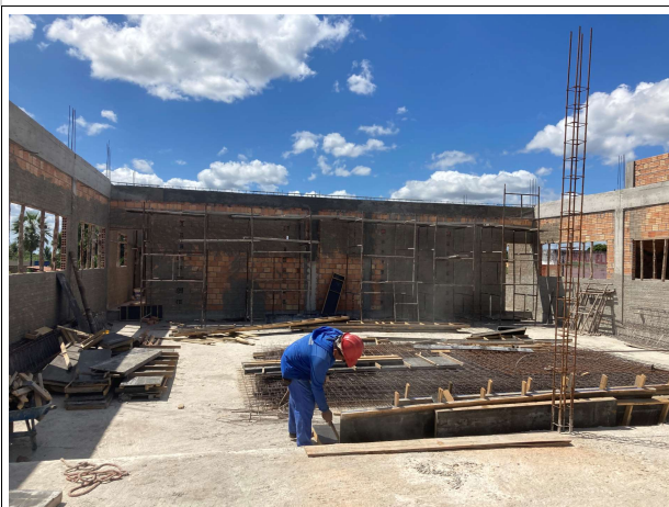
Fig. 5 – Execução de superestrutura
