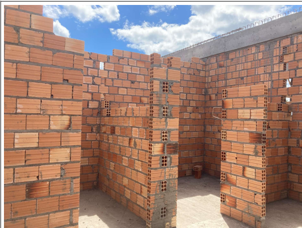
Fig. 9 – Execução de alvenaria
