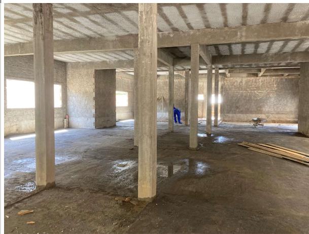
Fig. 7 – Contrapiso e revestimentos
