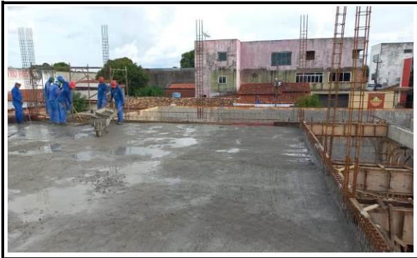
CONCRETAGEM LAJE
