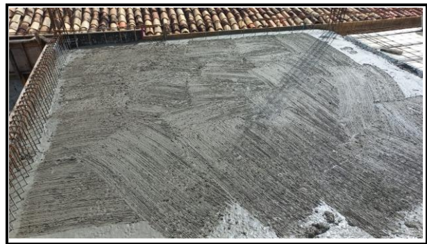
CONCRETAGEM LAJE
