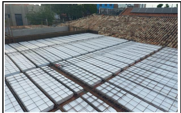
MONTAGEM ARMADURA/ENCHIMENTO (LAJE)
