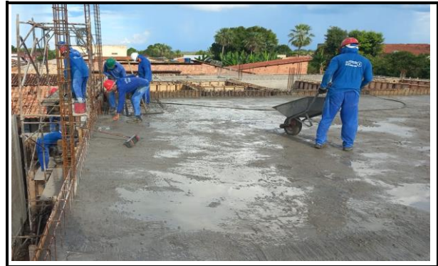
CONCRETAGEM LAJE
