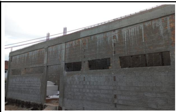
ELEMENTOS CONCRETO ARMADO 1º PAVIMENTO
