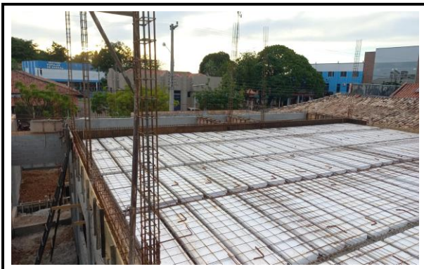
MONTAGEM ARMADURA/ENCHIMENTO (LAJE)
