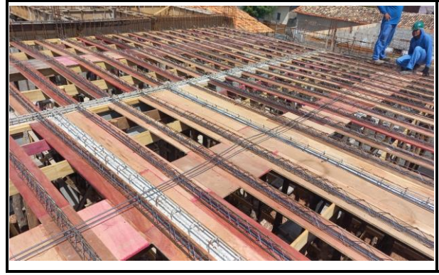
MONTAGEM FORMA/ARMADURA (LAJE)
