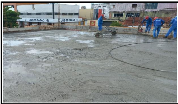
CONCRETAGEM LAJE
