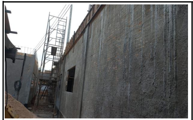
ELEMENTOS CONCRETO ARMADO 1º PAVIMENTO
