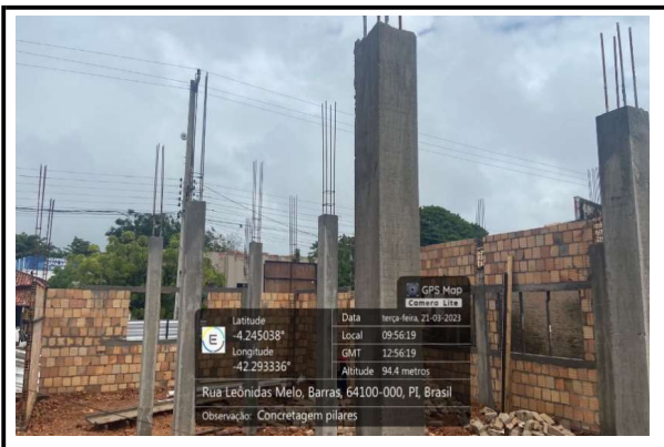
CONCRETAGEM PILARES
