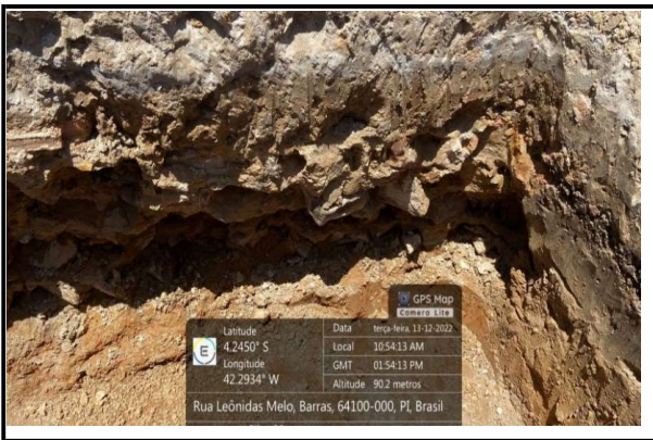
ESCAVAÇÃO DE SAPATA MATERIAL DE 2ª CATEGORIA
