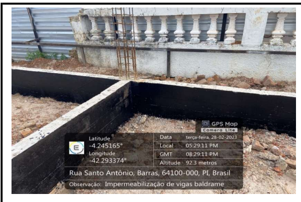
IMPERMEABILIZAÇÃO VIGAS BALDRAME
