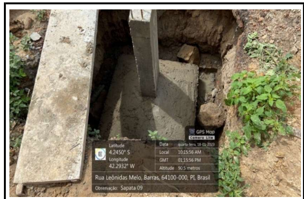
CONCRETAGEM SAPATA
