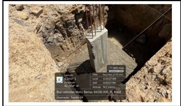
CONCRETAGEM DA SAPATA
