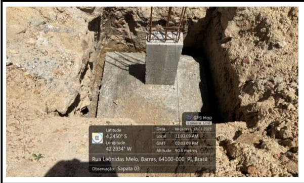
CONCRETAGEM DA SAPATA
