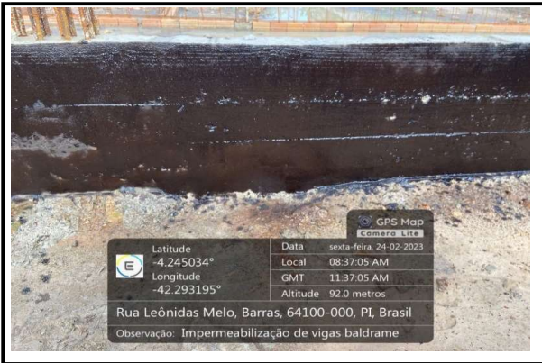
IMPERMEABILIZAÇÃO VIGAS BALDRAME
