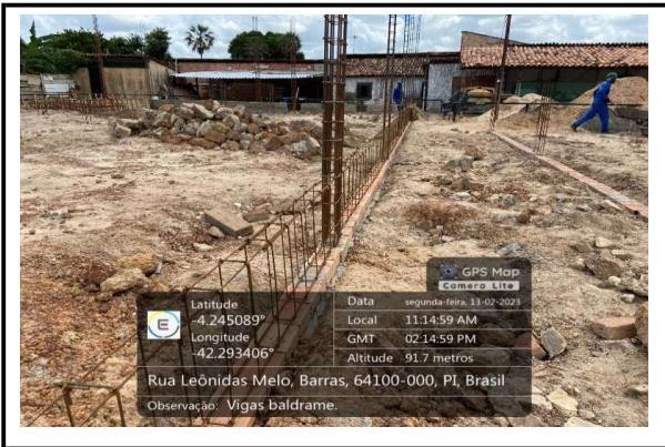
LOCAÇÃO VIGAS E PILARES
