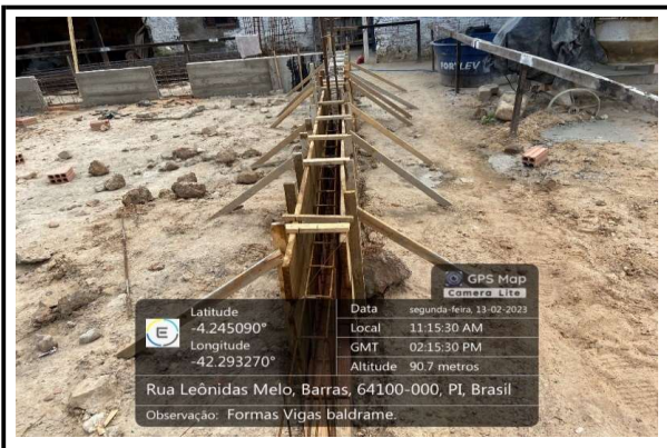
FORMAS VIGAS BALDRAME
