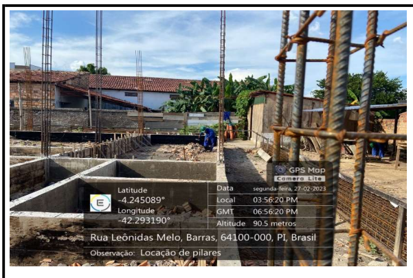
LOCAÇÃO DE PILARES
