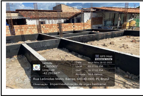
IMPERMEABILIZAÇÃO VIGAS BALDRAME
