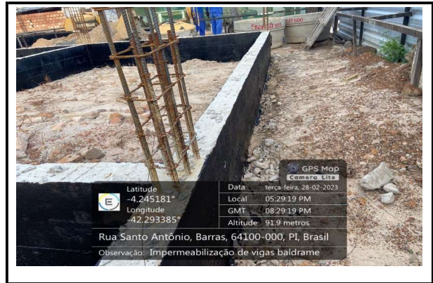
IMPERMEABILIZAÇÃO VIGAS BALDRAME
