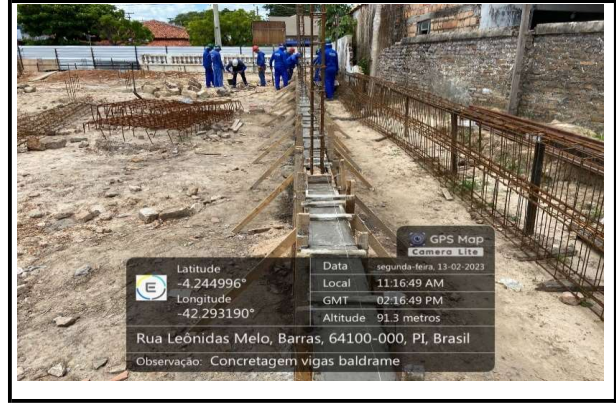
CONCRETAGEM VIGAS BALDRAME
