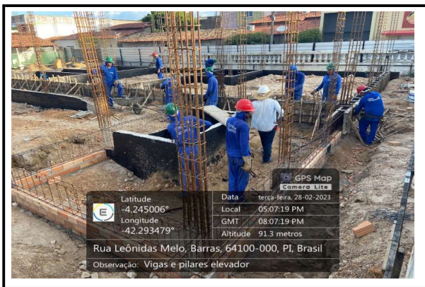
VIGAS E PILARES ELEVADOR
