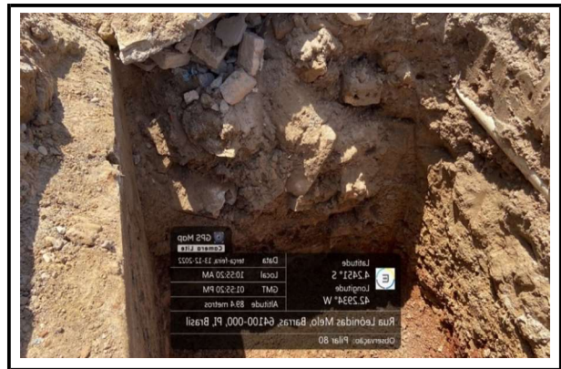
ESCAVAÇÃO DE SAPATA MATERIAL DE 2ª CATEGORIA
