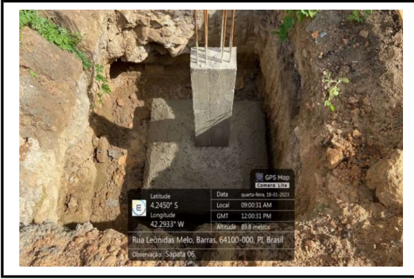
CONCRETAGEM SAPATA
