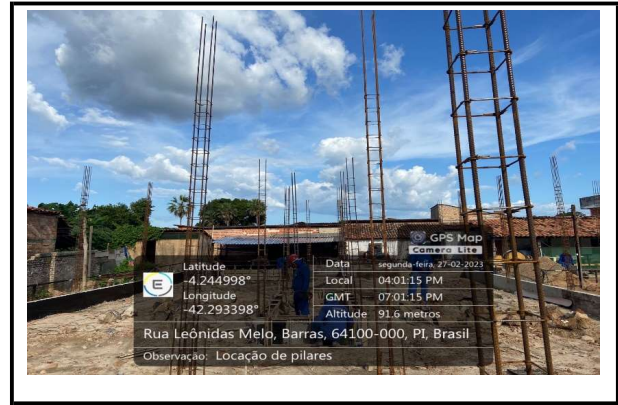
LOCAÇÃO DE PILARES
