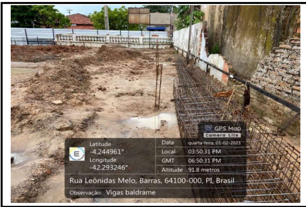
ARMAÇÃO VIGAS BALDRAME
