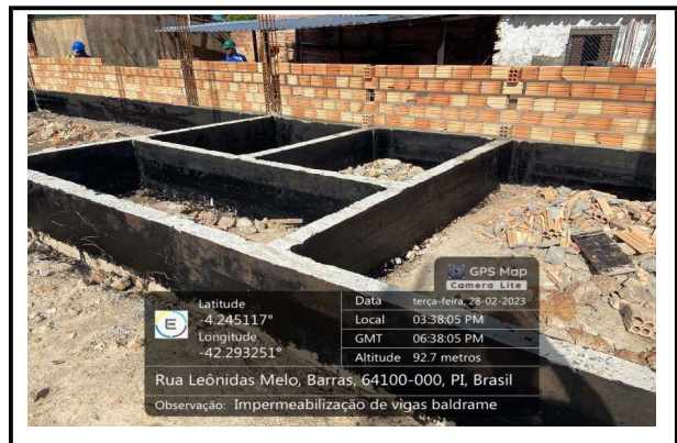
IMPERMEABILIZAÇÃO VIGAS BALDRAME
