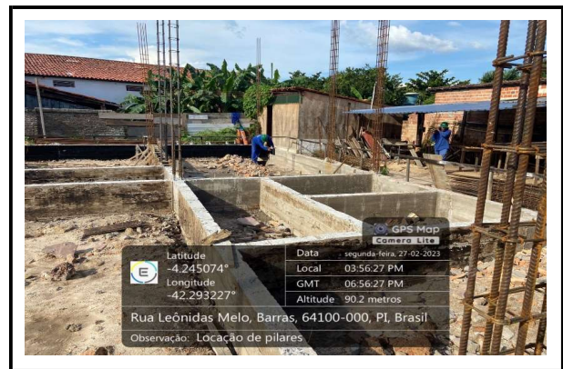
LOCAÇÃO DE PILARES
