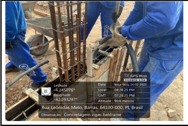
CONCRETAGEM VIGAS BALDRAME
