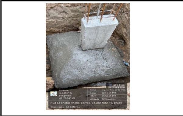
CONCRETAGEM DA SAPATA
