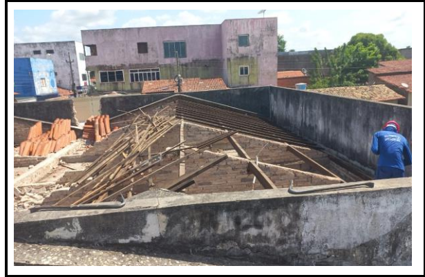
REMOÇÃO DE TELHA
