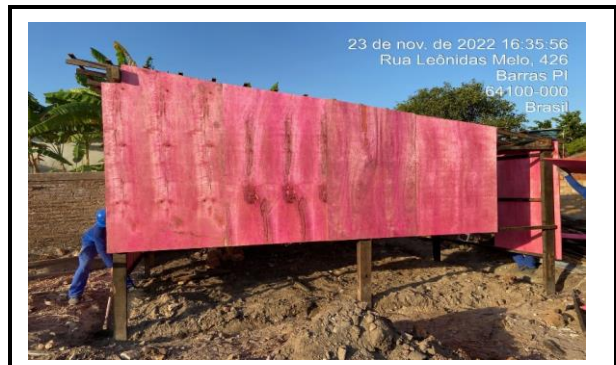
EXECUÇÃO DO VESTIÁRIO
