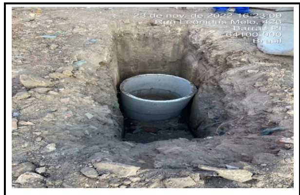
EXECUÇÃO DA FOSSA PARA O CANTEIRO DE OBRAS
