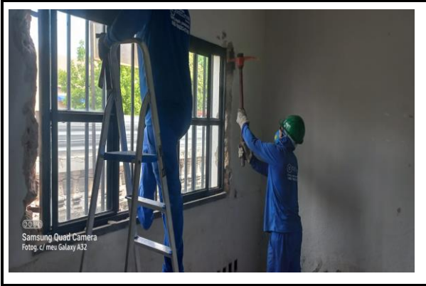
REMOÇÃO DAS JANELAS
