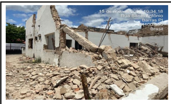
DEMOLIÇÃO DE PILARES E ALVENARIA
