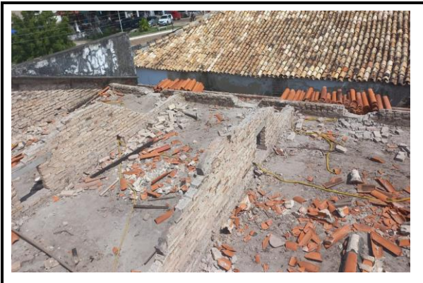
REMOÇÃO DA MADEIRA DO TELHADO
