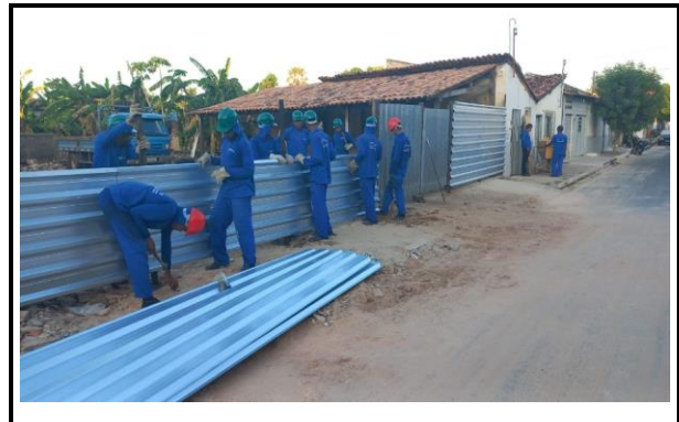
EXECUÇÃO DO TAPUME
