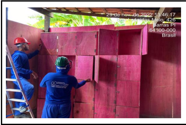
EXECUÇÃO DOS ARMÁRIOS DO VESTIÁRIO
