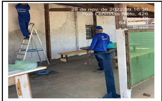
EXECUÇÃO DO REFEITORIO
