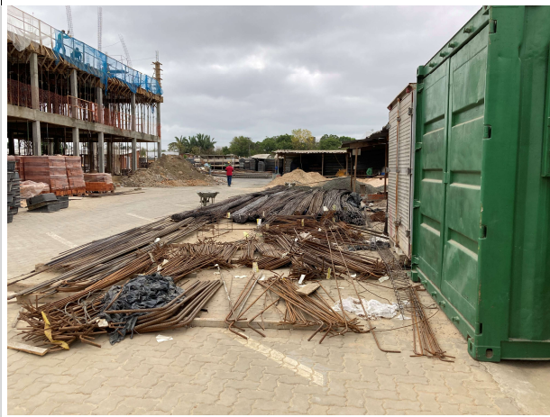
Fig. 7 – Ferragens da estrutura do Auditório
