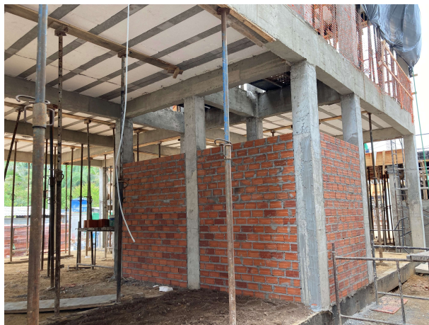
Fig. 3 – Execução de alvenaria da SUGESQ
