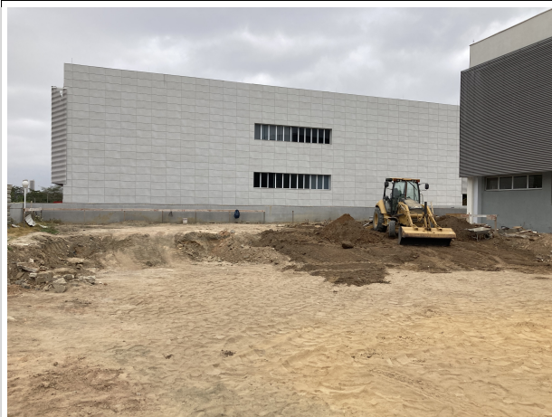
Fig. 9 – Escavações do Auditório
