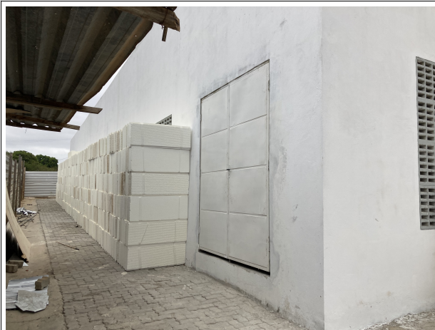
Fig. 11 – EPS da laje (SUGESQ)
