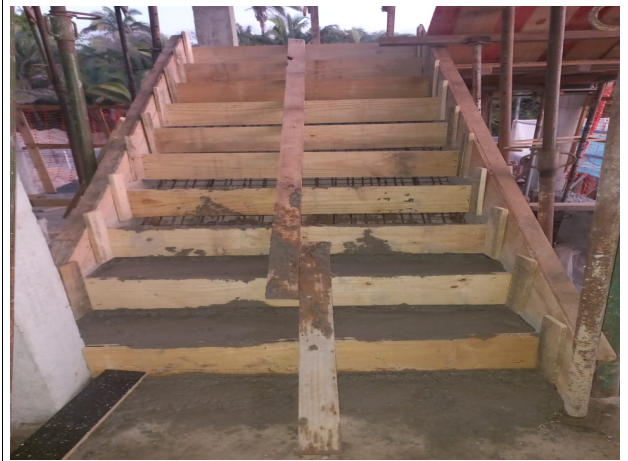
Fig. 14 – Concretagem da escada (SUGESQ)
