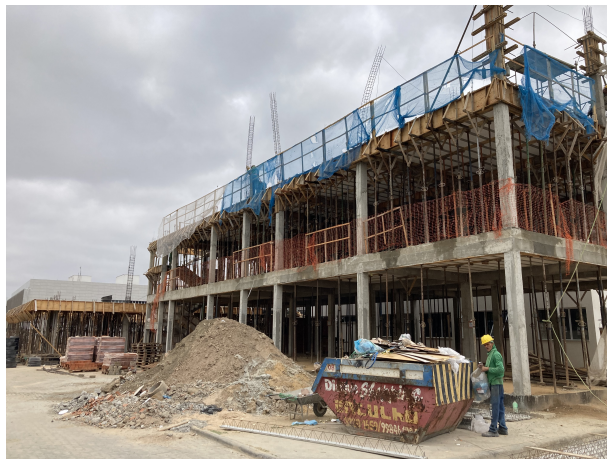
Fig. 1 – Execução de superestrutura da SUGESQ
