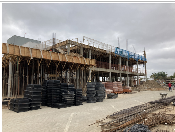
Fig. 5 – Execução de superestrutura do Auditório
