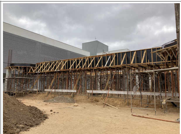
Fig. 6 – Execução de vigas do Auditório
