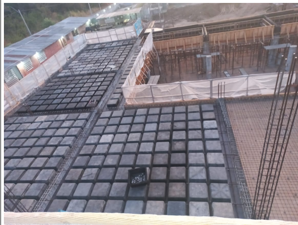
Fig. 13 – Concretagem da laje nervurada (Auditório)
