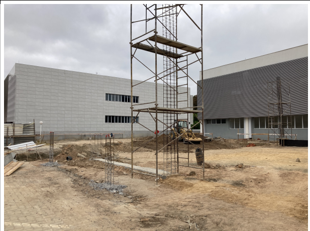
Fig. 10 – Pilares do Auditório
