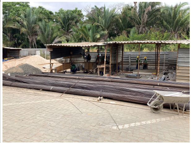
Fig. 8 – Ferragens da estrutura do Auditório
