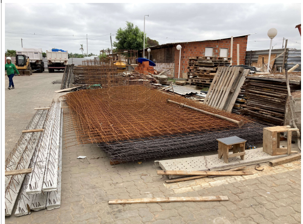
Fig. 4 – Trelças e malha da laje (SUGESQ)
