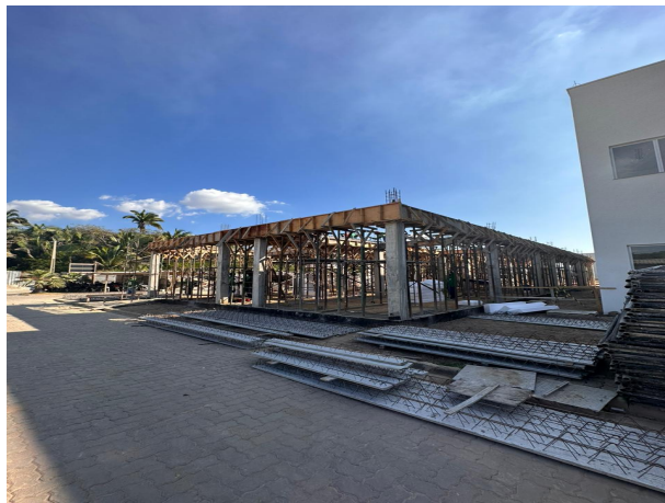
Fig. 1 – Execução de superestrutura da SUGESQ
