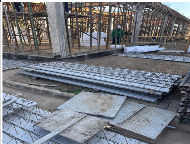
Fig. 7 – Treliças e EPS da laje da SUGESQ
