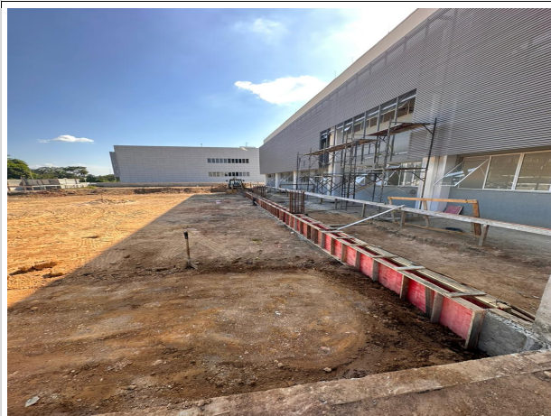
Fig. 9 – Execução do baldrame do Auditório
