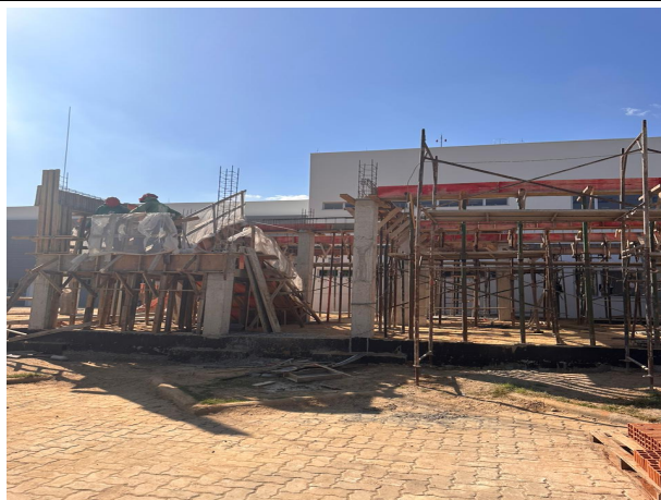
Fig. 3 – Execução de superestrutura da SUGESQ
