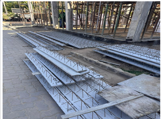
Fig. 2 – Treliças da laje da SUGESQ
