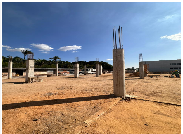
Fig. 8 – Pilares do Auditório
