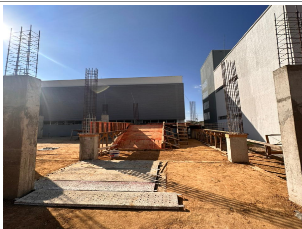
Fig. 5 – Execução de superestrutura do Auditório
