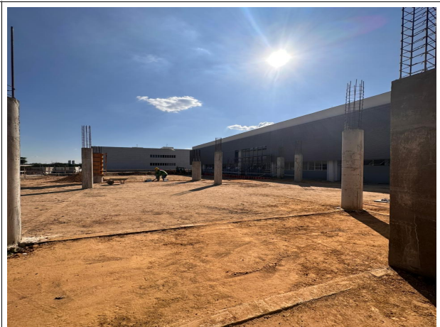
Fig. 6 – Execução de superestrutura do Auditório
