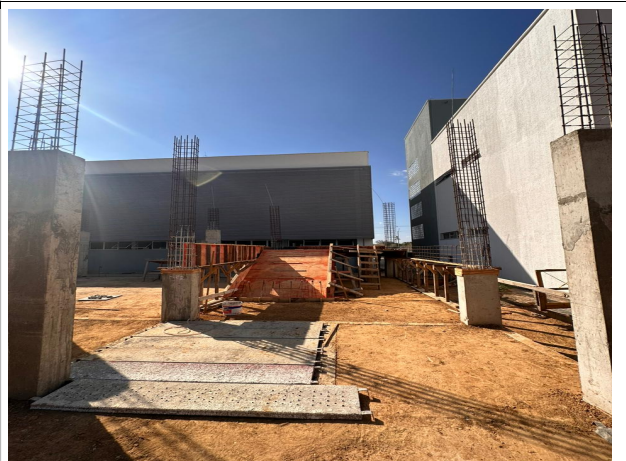
Fig. 10 – Execução da escada da SUGESQ
