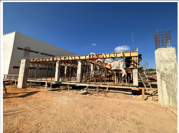
Fig. 4 – Execução de superestrutura da SUGESQ
