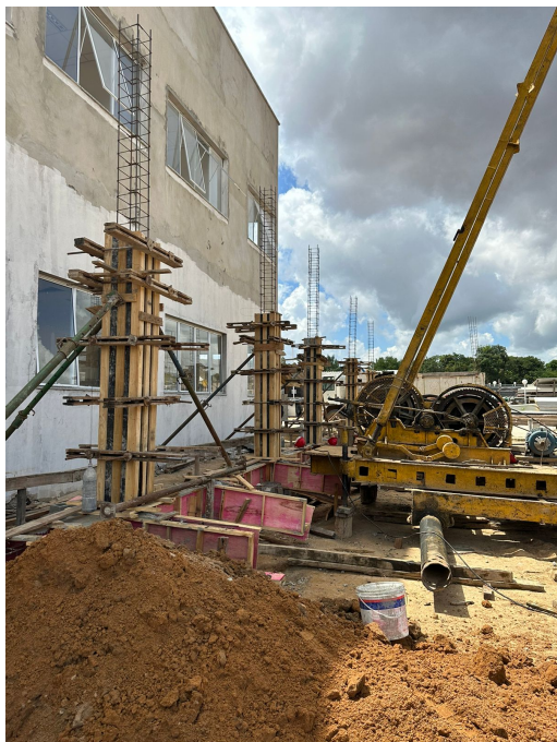
Foto 11 – Cintamento inferior e pilares na SUGESQ
