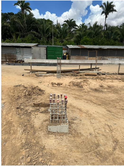
Foto 5 – Sapatas concretadas e aterradas do Auditório
