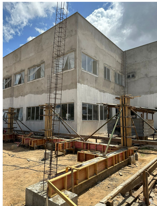
Foto 12 – Blocos, cintamento inferior e pilares na SUGESQ
