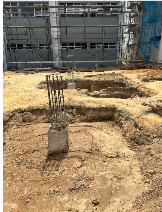
Foto 6 – Sapatas concretadas e aterradas do Auditório
