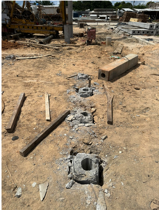
Foto 9 – Estacas pré-moldadas cravadas na SUGESQ
