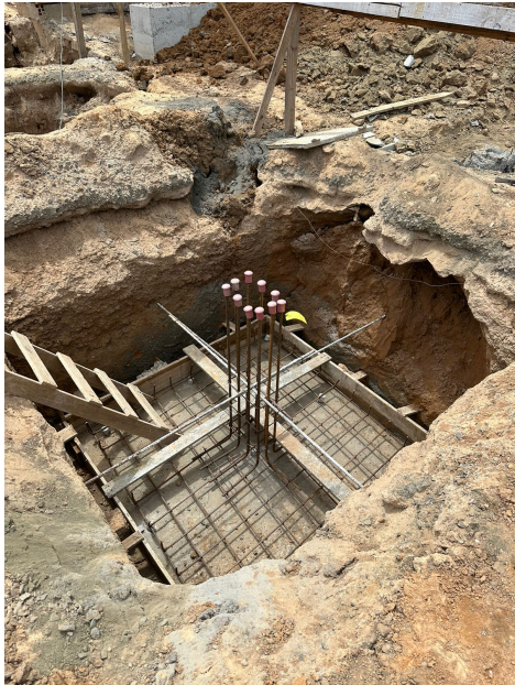
Foto 1 – Ferragem de sapatas montadas do Auditório
