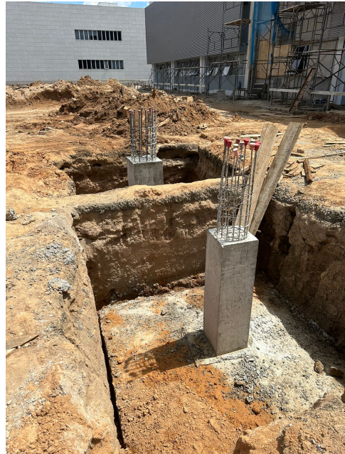
Foto 2 – Sapatas concretadas do Auditório
