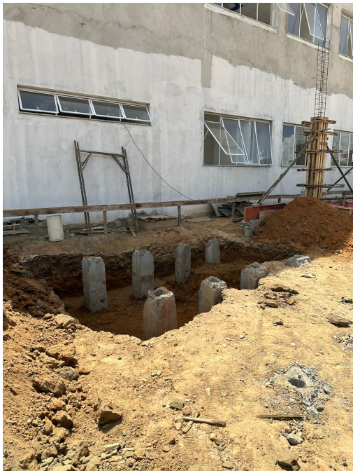
Foto 7 – Estacas pré-moldadas cravadas na SUGESQ
