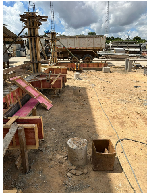
Foto 8 – Estacas moldadas inloco executadas SUGESQ
