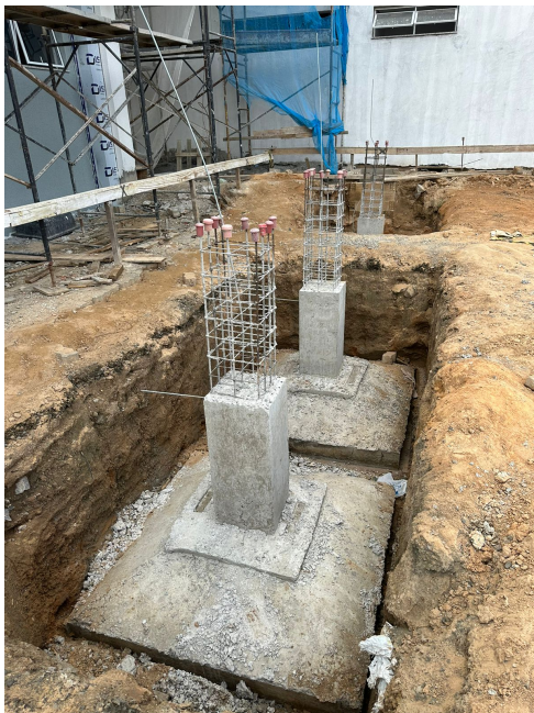
Foto 3 – Sapatas concretadas do Auditório
