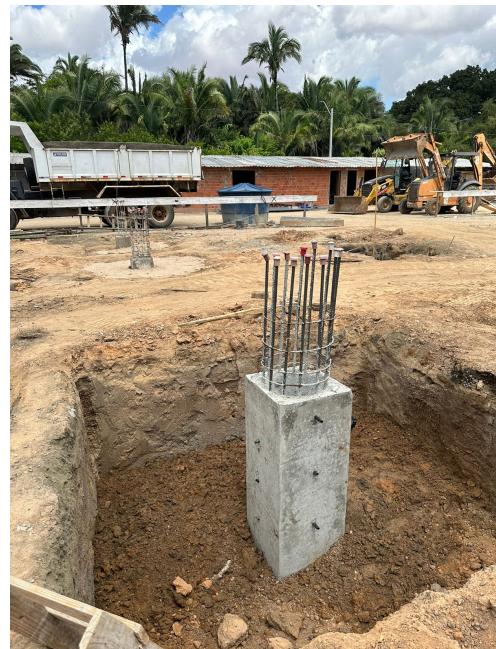
Foto 4 – Pescoço de pilar concretado do Auditório
