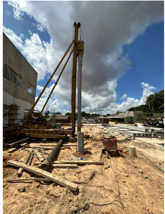
Foto 10 – Estacas pré-moldadas cravadas na SUGESQ
