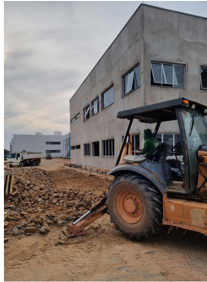
Foto 2 – Retirada de paver Auditório e SUGESQ
