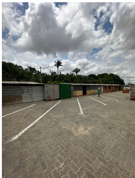
Foto 7 – Canteiro de obras
