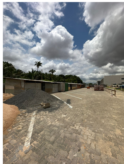
Foto 8 – Canteiro de obras
