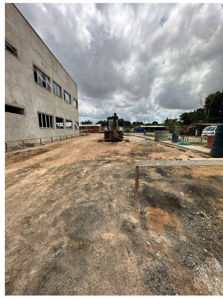
Foto 4 – Limpeza terreno SUGESQ
