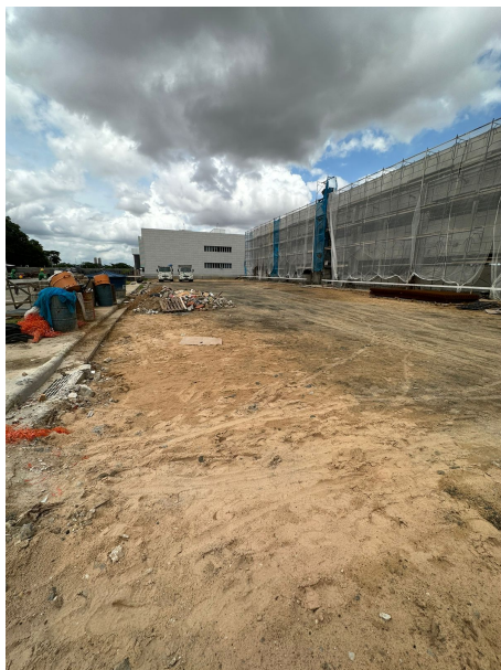
Foto 3 – Limpeza terreno Auditório
