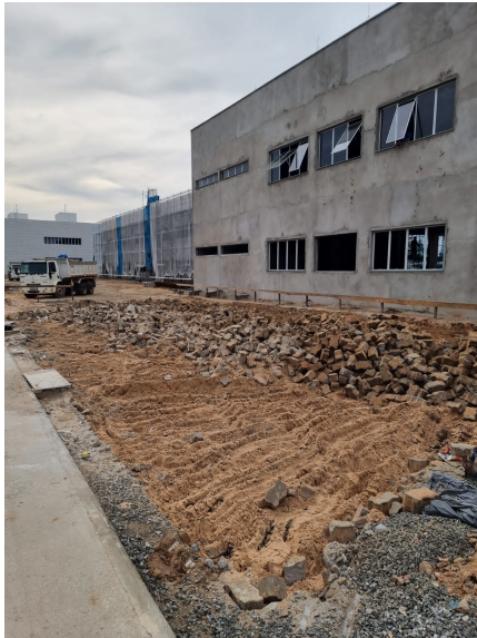
Foto 1 – Retirada de paver Auditório e SUGESQ
