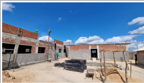
8-PAREDES E VEDAÇÃO/ 12-REVESTIMENTO
