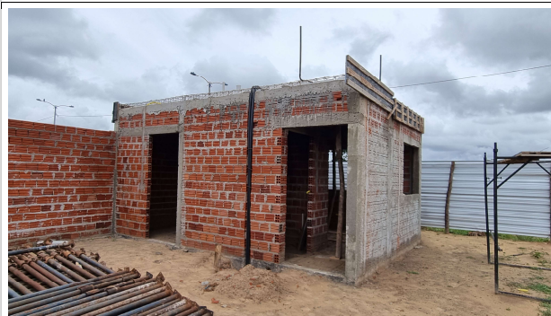
6-SUPERESTRUTURA/ 8-PAREDES E VEDAÇÃO
