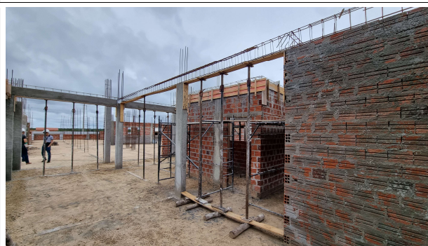
6-SUPERESTRUTURA/ 8-PAREDES E VEDAÇÃO
