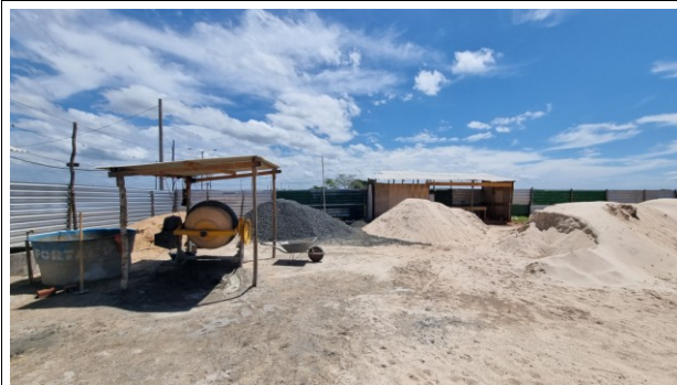
1-SERVIÇOS PRELIMINARES (CANTEIRO DE OBRAS)
