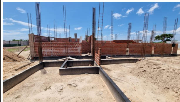
6-SUPERESTRUTURA ; 8-PAREDES DE VEDAÇÃO
