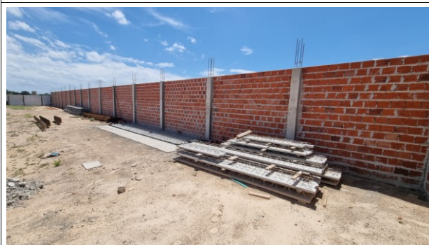
6-SUPERESTRUTURA ; 8-PAREDES DE VEDAÇÃO
