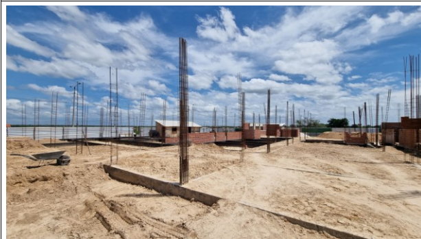
5-INFRAESTRUTURA (VIGA BALDRAME)
