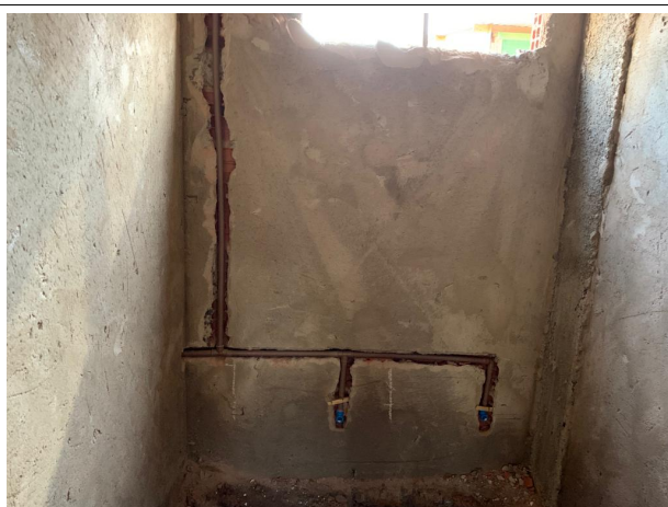
Fig.5- Instalações hidráulicas e sanitárias
