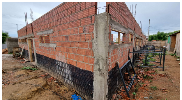
Fig.4- Impermeabilização/Infraestrutura/Superestrutura/Paredes
