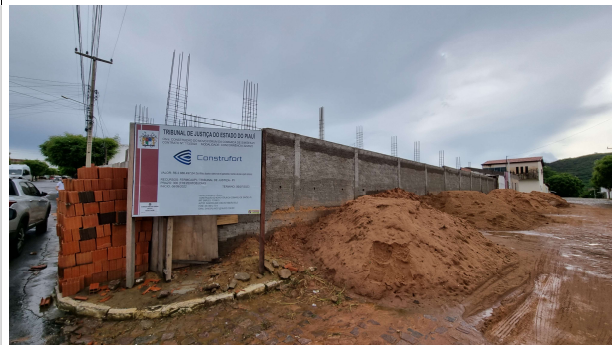
Fig. 1 - Serviços preliminares: instalação de placa de obra
