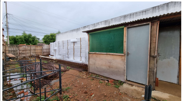
Fig. 2 - Serviços preliminares: apoio do canteiro de obra
