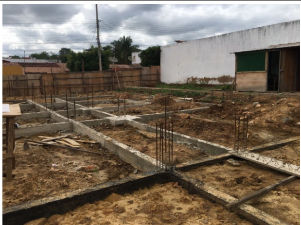
Fig. 4 - Impermeabilização do baldrame e infraestrutura
