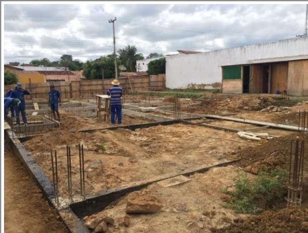
Fig. 3 - Impermeabilização do baldrame
