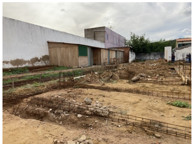
Fig. 2 - Serviços preliminares: apoio do canteiro de obra
