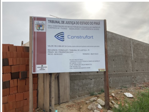
Fig. 1 - Serviços preliminares: instalação de placa de obra
