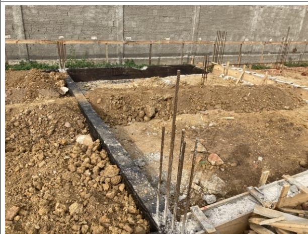
Fig. 5 - Impermeabilização e locação da obra
