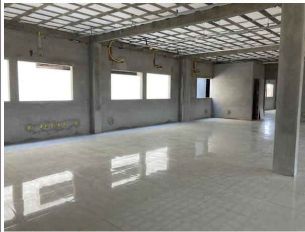
Fig. 9 – Execução de piso cerâmico e instalações
