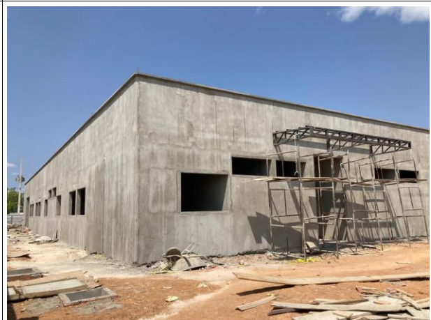
Fig. 12 – Aplicação de massa única
