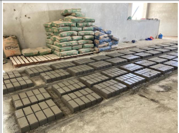
Fig. 8 – Fabricação de pavimento intertravado
