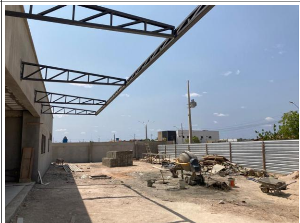
Fig. 14 – Estrutura metálica da marquise
