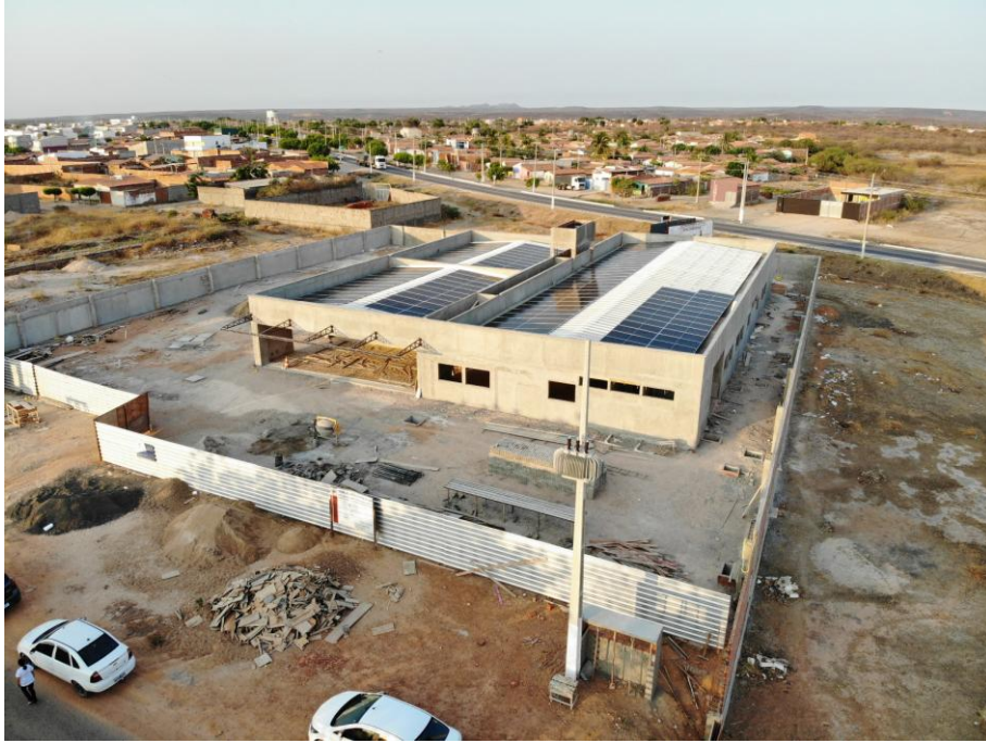
Fig. 1 – Vista aérea do terreno e da edificação
