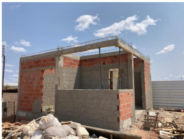
Fig. 5 – Execução da guarita
