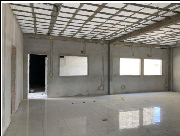
Fig. 11 – Execução de piso cerâmico e instalações
