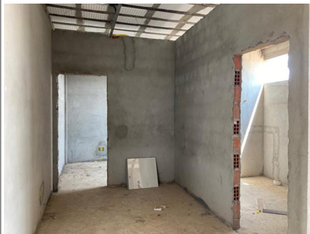
Fig. 17 – Aplicação de massa única
