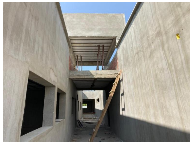
Fig. 16 – Estrutura da caixa d' água
