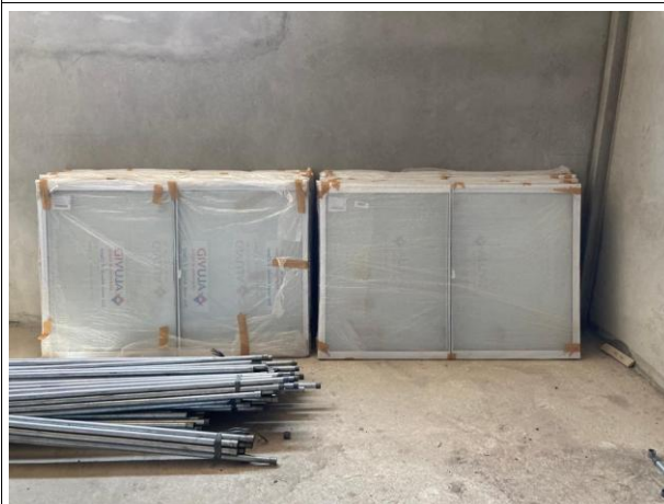
Fig. 13 – Esquadrias de alumínio e vidro
