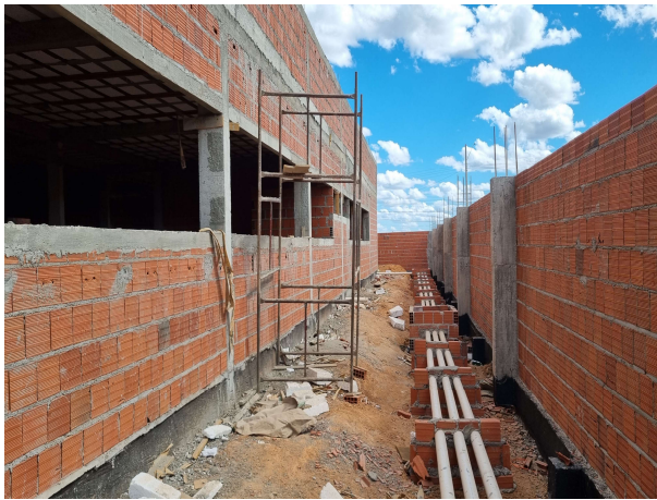
Fig. 7 – Execução de alvenaria e instalações
