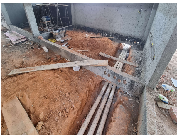
Fig. 11 – Instalações pluviais
