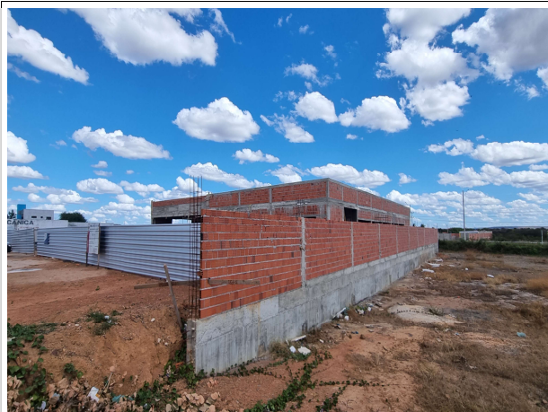
Fig. 1 – Exterior da edificação
