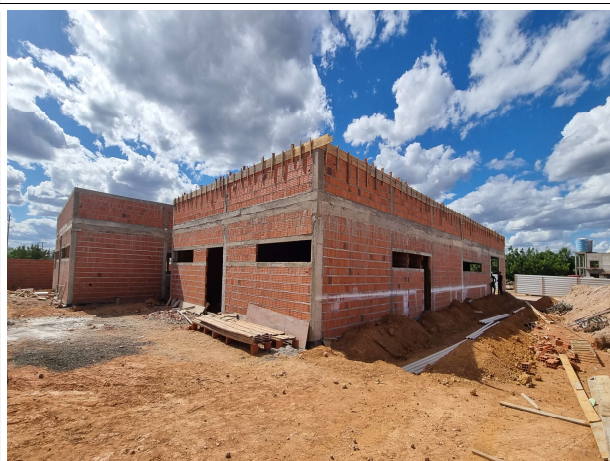
Fig. 4 – Fachada lateral do Fórum
