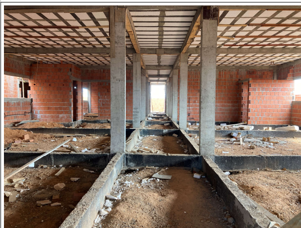
Fig. 5 – Baldrame impermeabilizado e Superestrutura
