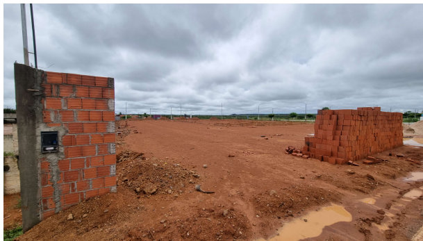
Fig. 1 – Ligação de energia
