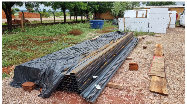
Fig. 2 – Canteiro de obras
