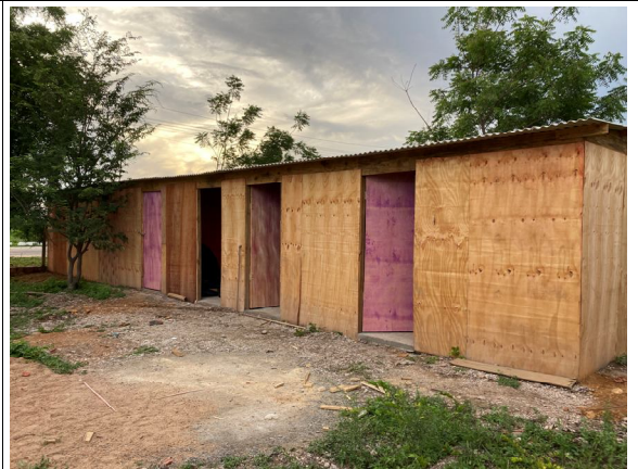
Fig. 2 – apoio do canteiro de obras
