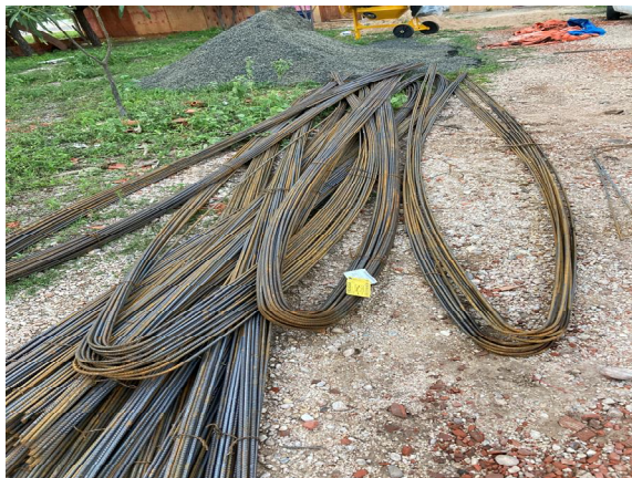
Fig. 9 – ferragens da fundação da edificação
