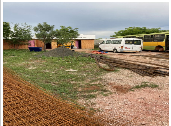
Fig. 4 – ferragens da fundação da edificação
