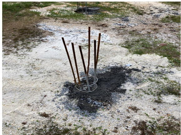
Fig. 10 – estacas da fundação do muro
