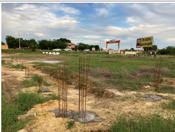
Fig. 5 – estacas da fundação do muro
