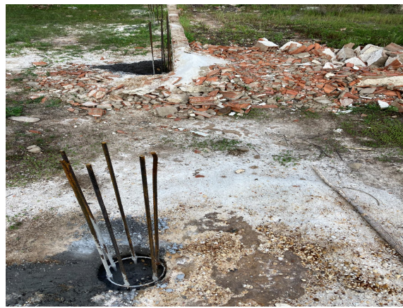
Fig. 7 – estacas da fundação do muro
