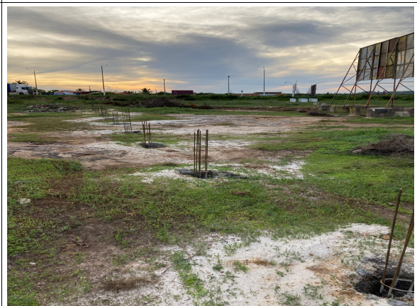
Fig. 6 – estacas da fundação do muro
