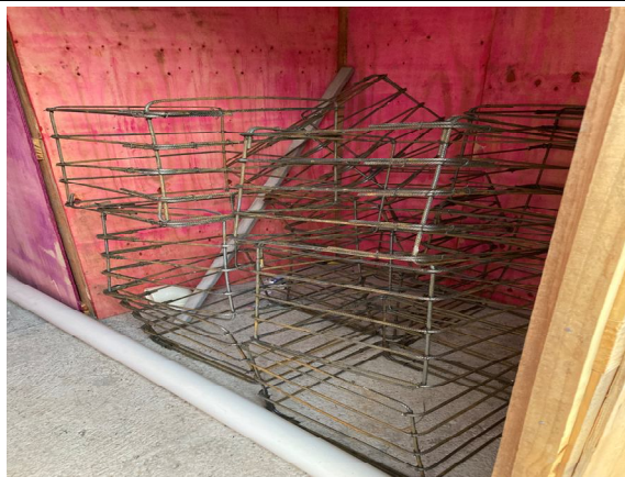
Fig. 3 – ferragens da fundação da edificação
