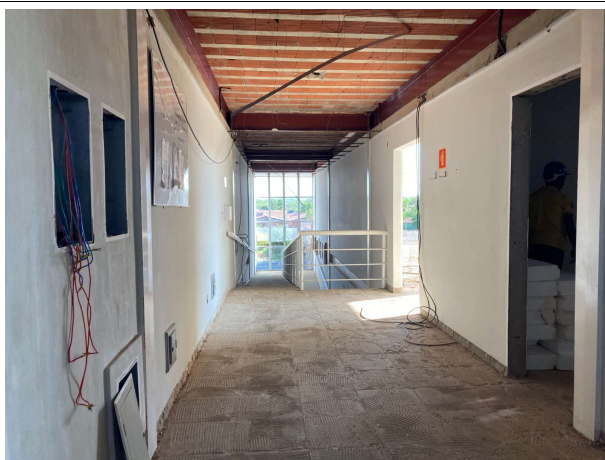
Fig. 5 – Execução de demolições
