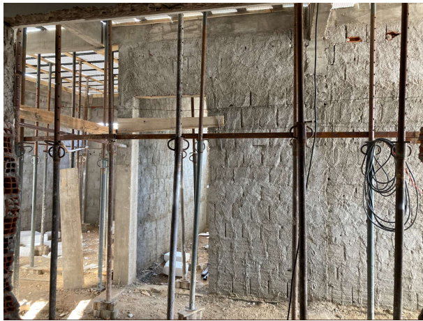
Fig. 7 – Execução de alvenaria e reboco
