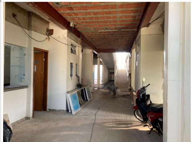
Fig. 4 – Execução de demolições
