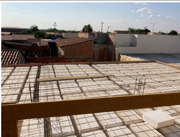
Fig. 9 – Execução de superestrutura
