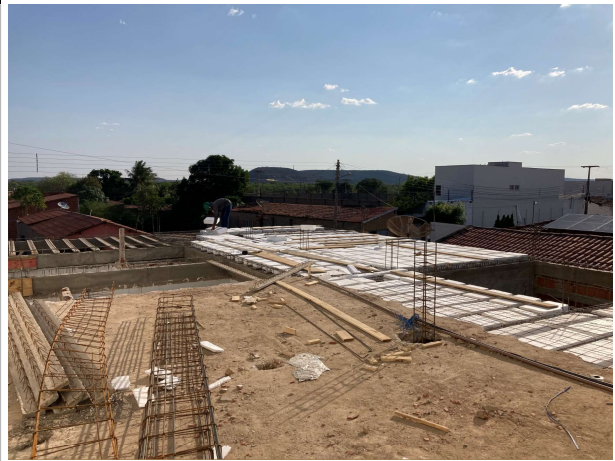
Fig. 8 – Execução de superestrutura
