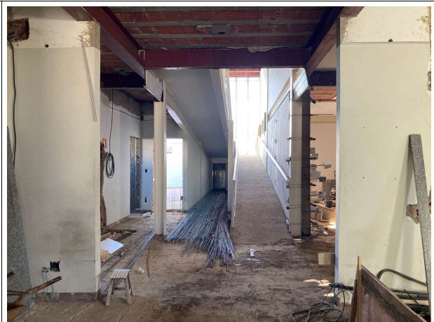
Fig. 6 – Execução de demolições
