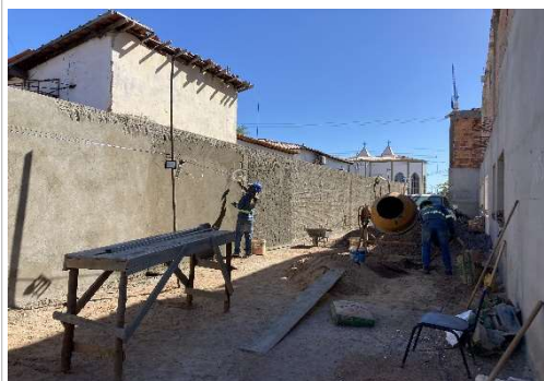
MURO/CHAPISCO/REBOCO
