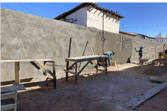
MURO/CHAPISCO/REBOCO
