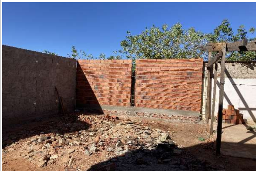
EXECUÇÃO DE FUNDÇÕES DO MURO/MURO
