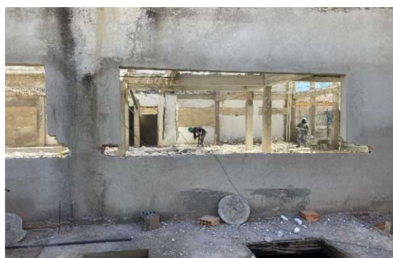
EXECUÇÃO DE VERGAS/REBOCO
