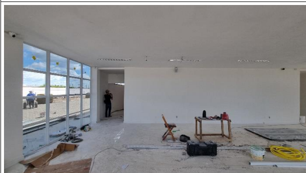
Fig. 9 – Pintura, Esquadrias, Instalações
