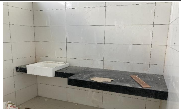
Fig. 14 – Revestimento, Instalações hidrossanitária, cuba e bancada em granito
