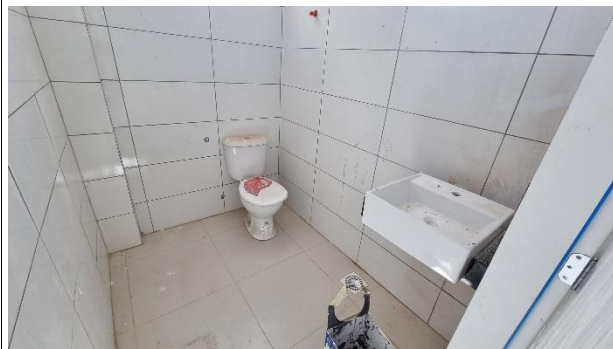
Fig. 11 – Revestimento, Instalações hidrossanitárias
