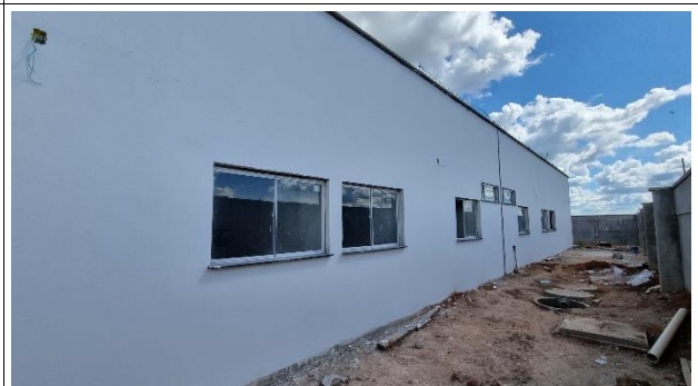
Fig. 10 – Revestimento, pintura e esquadrias
