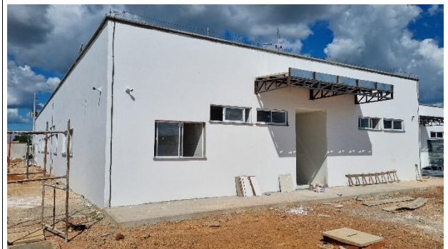
Fig. 4 – Fachada lateral e fundos
