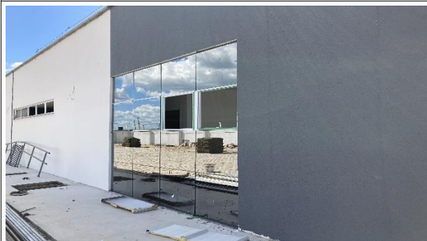
Fig. 7 – Execução de esquadrias
