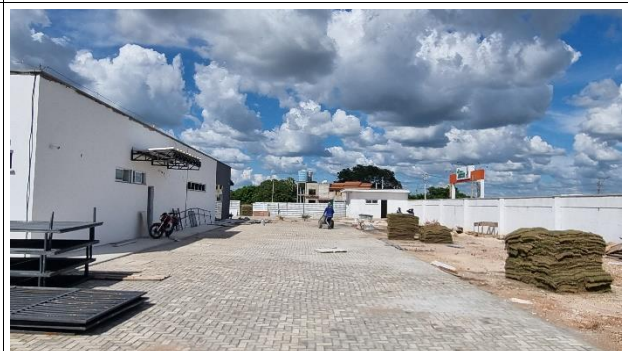
Fig. 6 – Execução de pavimento intertravado
