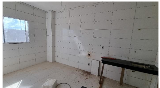
Fig. 12 –Revestimento, Instalações hidrossanitária
