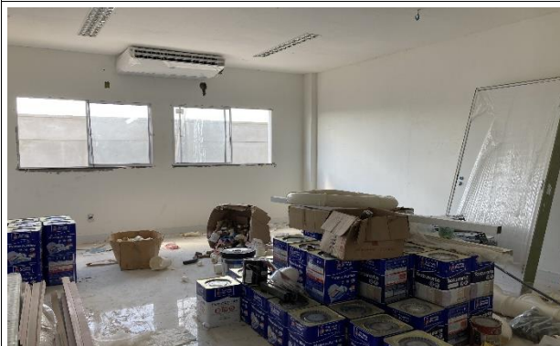
Fig. 13 – Pintura, Instalações de ar condicionado
