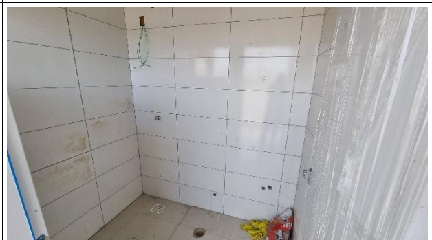
Fig. 10 – Instalações hidrossanitárias, revestimento e esquadrias
