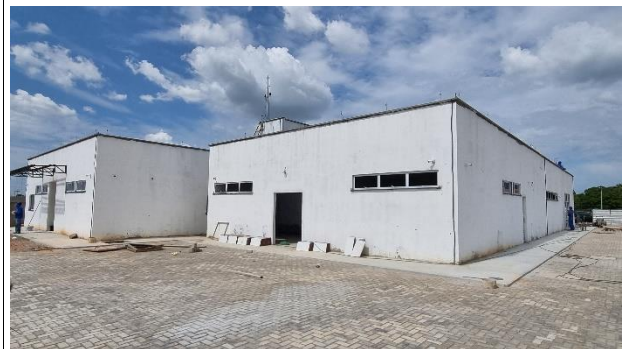
Fig. 4 – Fachada lateral e fundos
