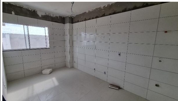
Fig. 11 – Revestimento, Instalações hidrossanitárias
