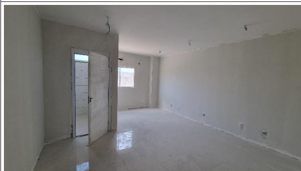
Fig. 9 – Pintura, Esquadrias, Instalações
