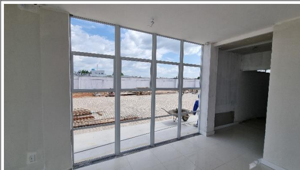
Fig. 7 – Execução de esquadrias
