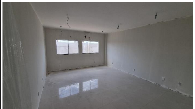
Fig. 12 – Pintura, instalações elétricas e lógicas
