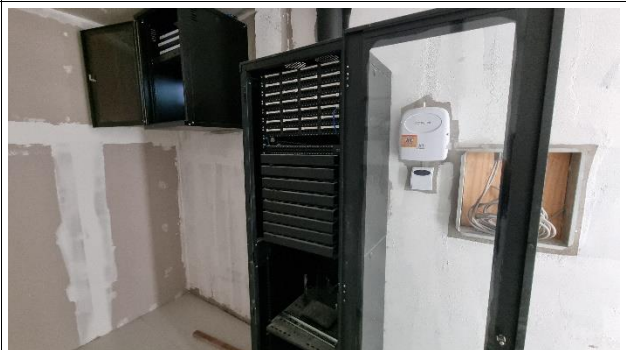
Fig. 14 – Execução de instalações lógicas
