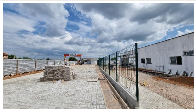
Fig. 6 – Execução de pavimento intertravado
