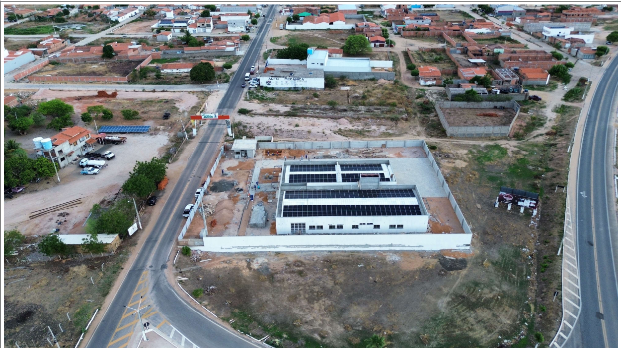
Fig. 2 – Vista aérea da obra
