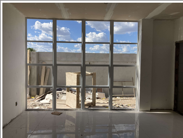
Fig. 19 – Execução de esquadrias
