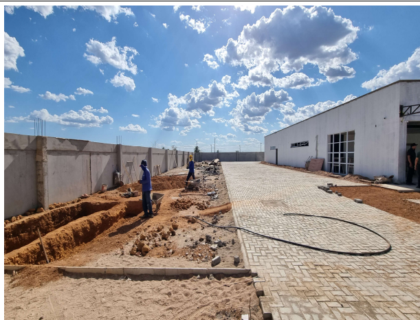
Fig. 5 – Execução de instalações hidrossanitárias
