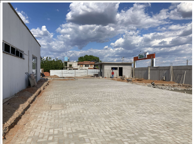
Fig. 6 – Execução de pavimento intertravado
