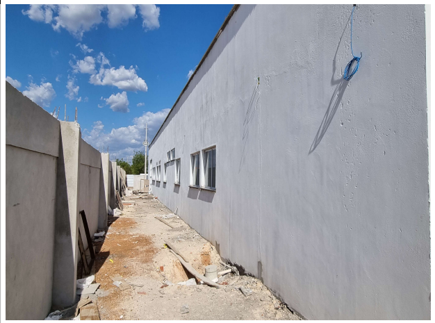
Fig. 4 – Execução de pintura e esquadrias na fachada
