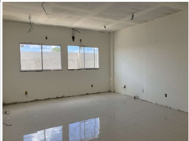
Fig. 10 – Execução de forro, piso e instalações elétricas
