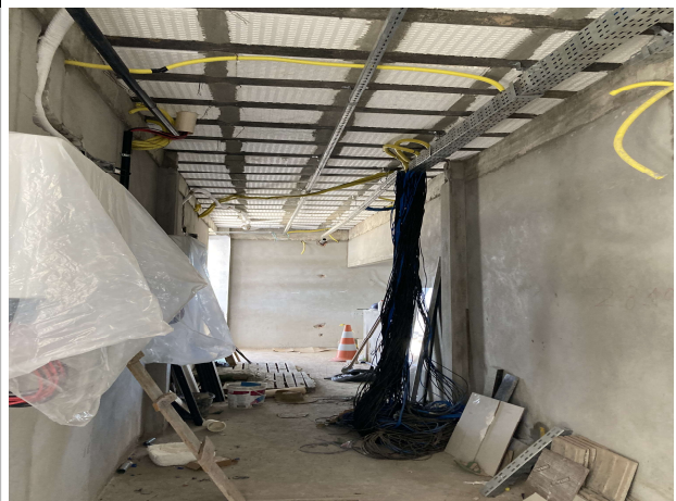
Fig. 12 – Execução de instalações elétricas e lógicas
