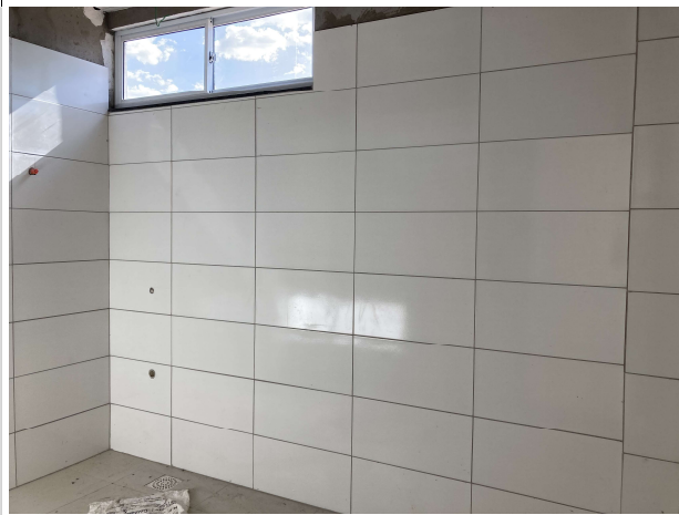
Fig. 15 – Execução de revestimentos
