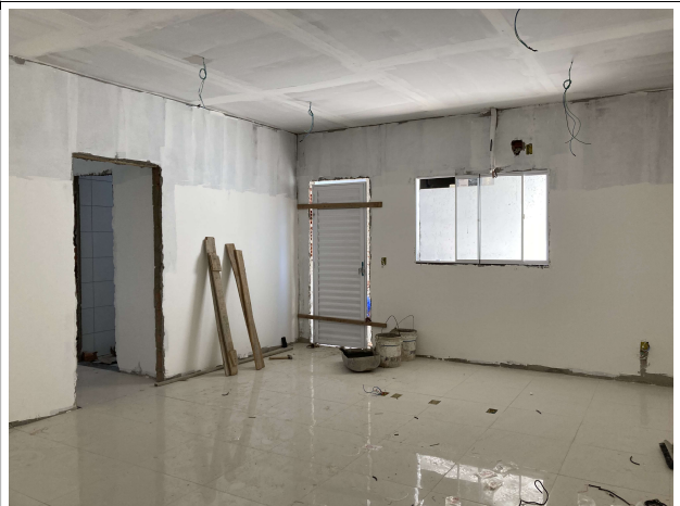
Fig. 18 – Execução de instalações e esquadrias
