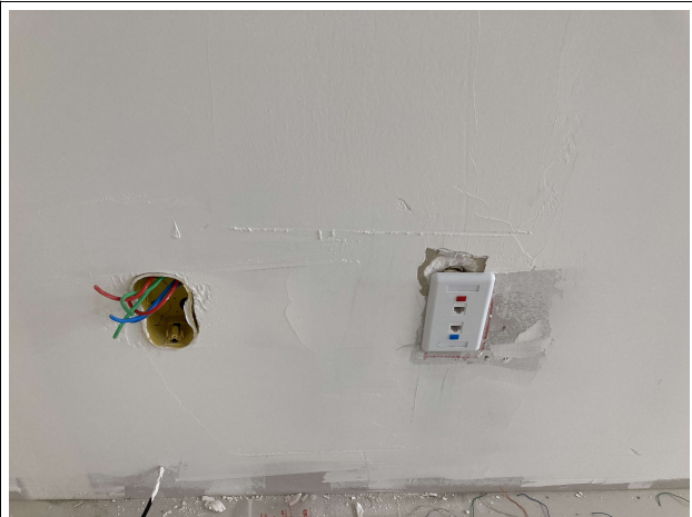
Fig. 14 – Execução de instalações elétricas e lógicas
