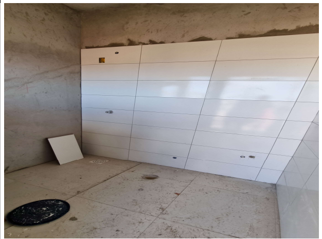
Fig. 16 – Execução de revestimentos e instalações sanitárias
