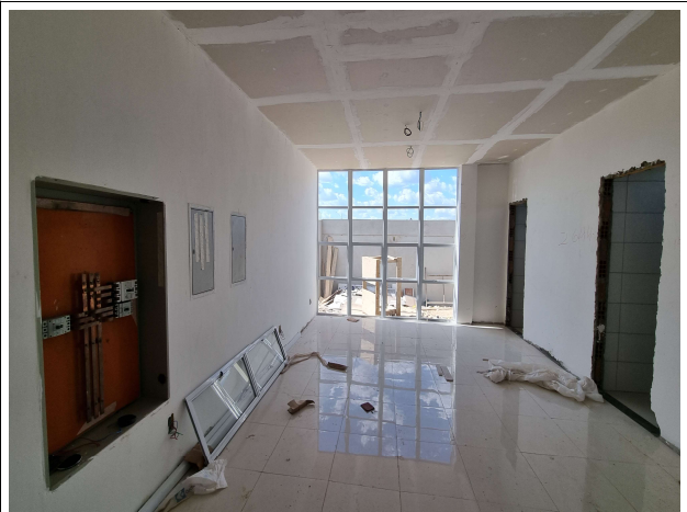
Fig. 8 – Execução de forro, piso e esquadrias
