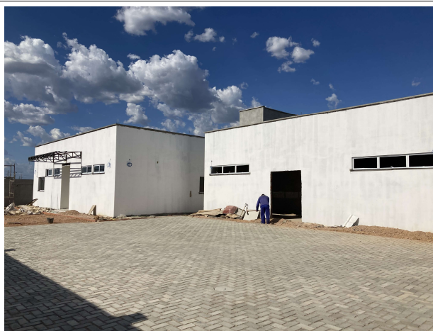
Fig. 7 – Execução de pintura
