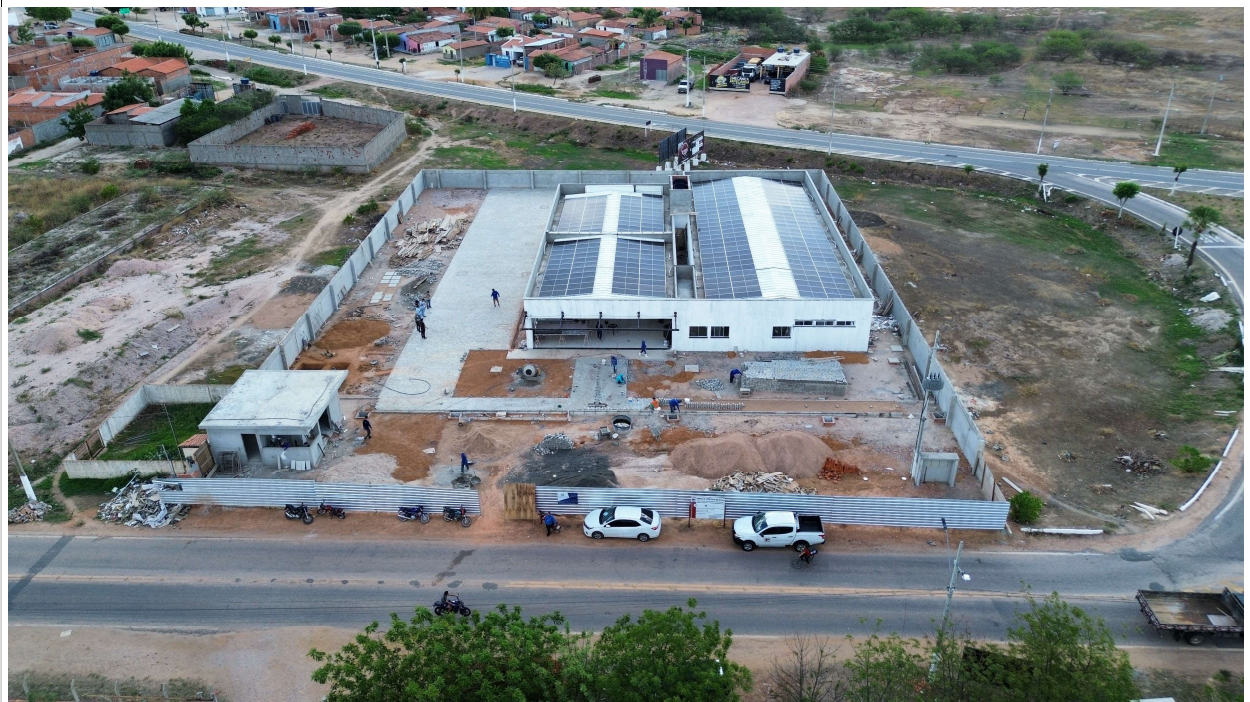
Fig. 1 – Vista aérea da obra
