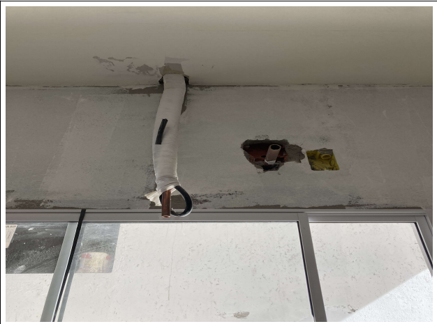
Fig. 20 – Execução de esquadrias e HVAC
