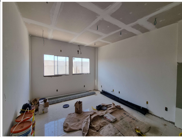
Fig. 9 – Execução de instalações, forro e paredes de drywall
