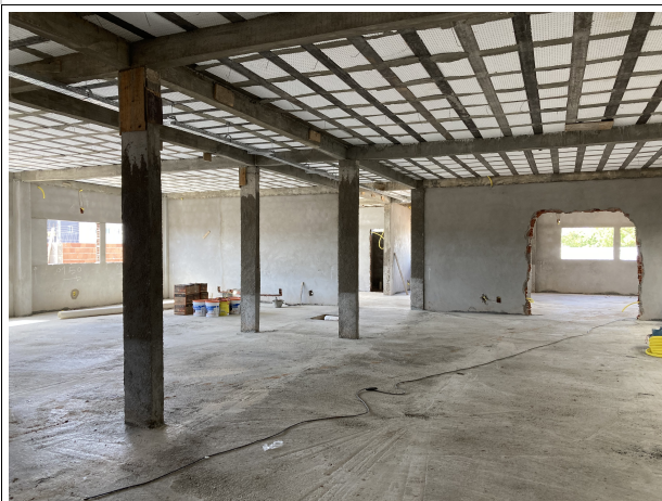
Fig. 5 – Contrapiso e estruturas de concreto
