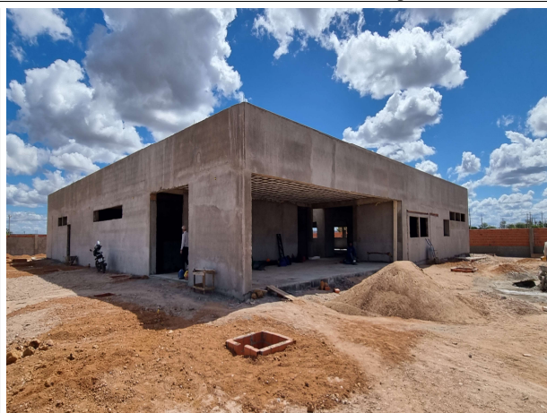
Fig. 2 – Fachada frontal do Fórum
