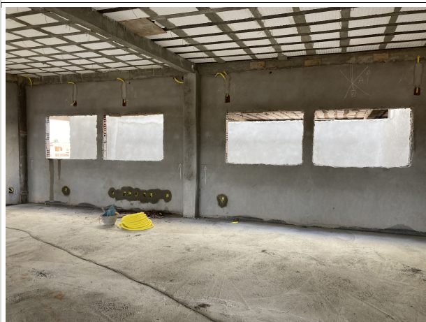
Fig. 3 – Execução de instalações, contrapiso e reboco
