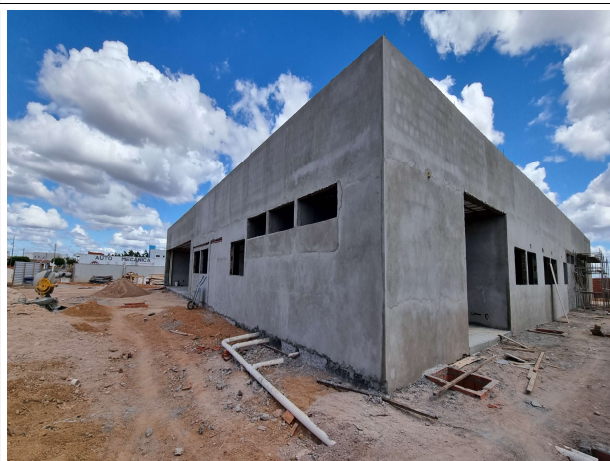
Fig. 4 – Fachada lateral do Fórum
