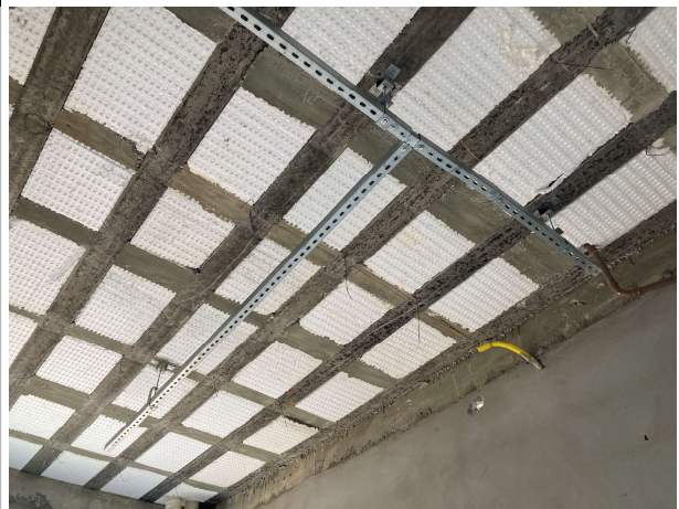
Fig. 8 – Execução de instalações elétricas
