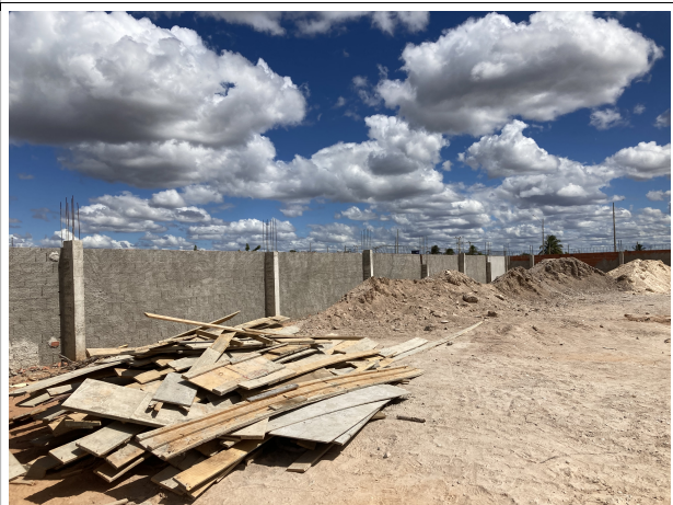
Fig. 10 – Muro do terreno
