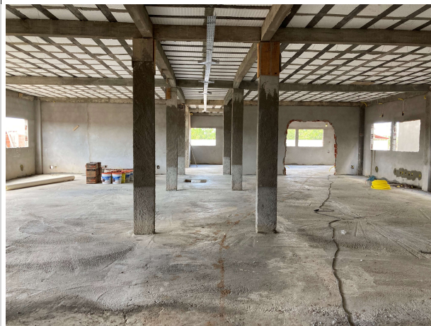
Fig. 7 – Contrapiso e estrutura de concreto
