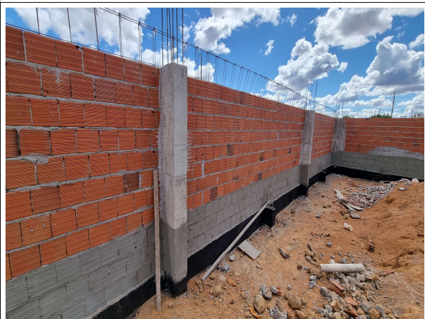
Fig. 12 – Impermeabilização do muro
