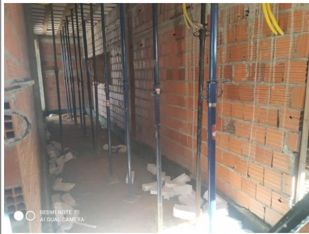
Fig. 7 – Superestrutura
